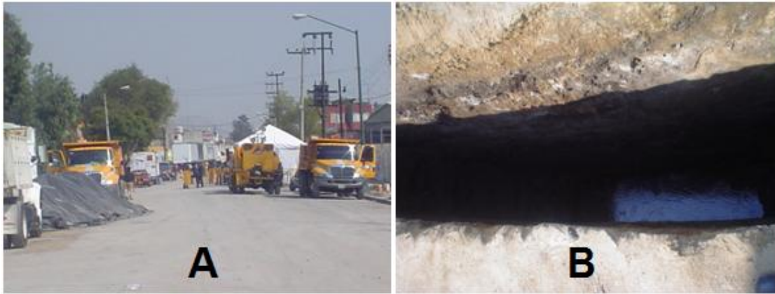
Figura III.2: A) Vista de la calle principal en el área de estudio. B) Excavaciones realizadas.
