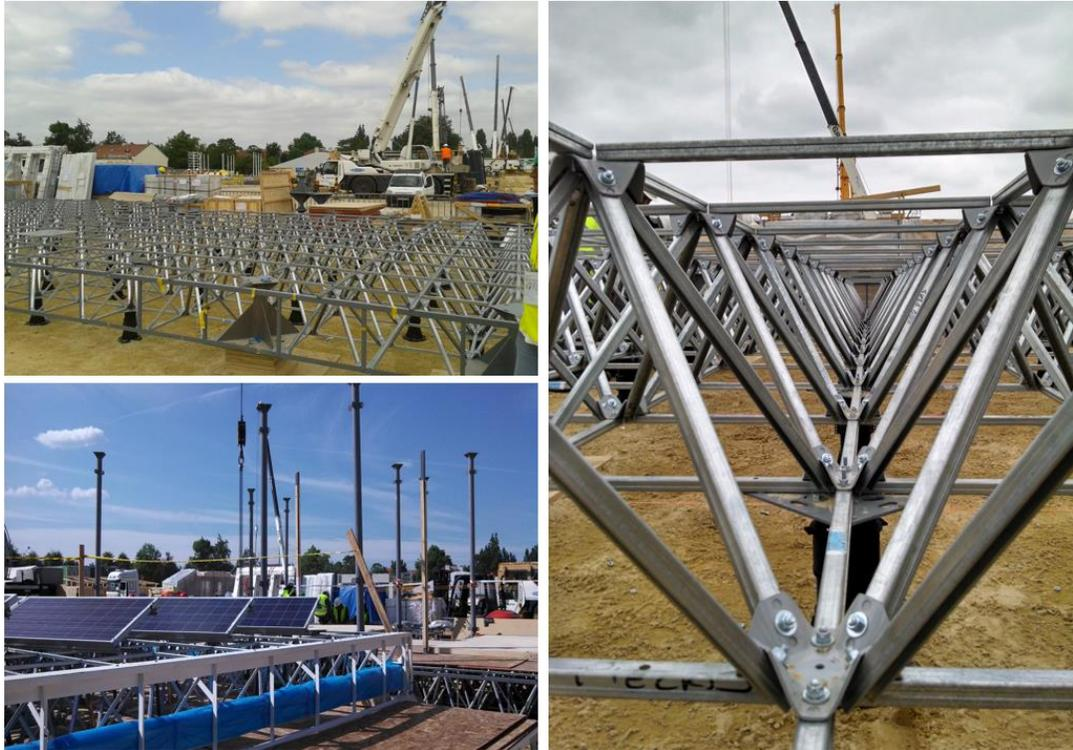
**Fig. 39** Construcción de las plataformas tridimensionales.
