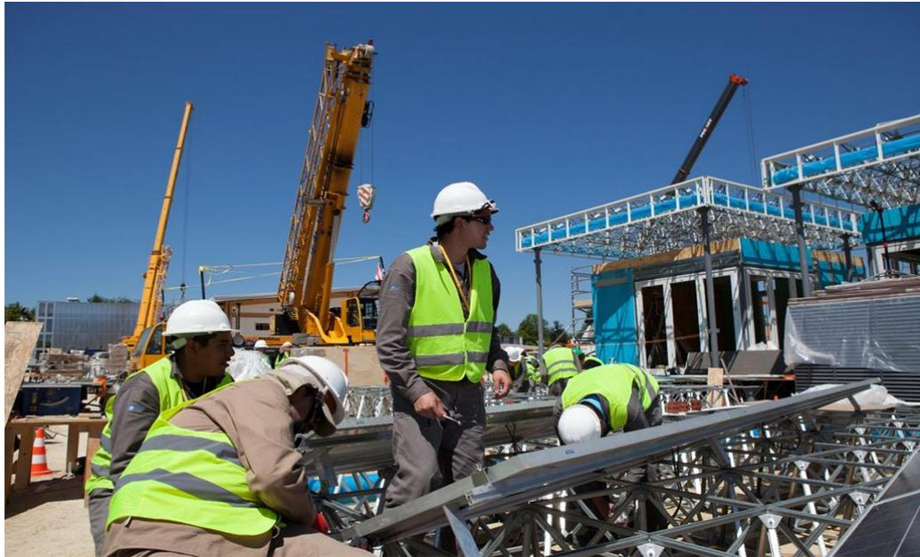
**Fig. 41** Instalación de bastidores sobre cubierta.
