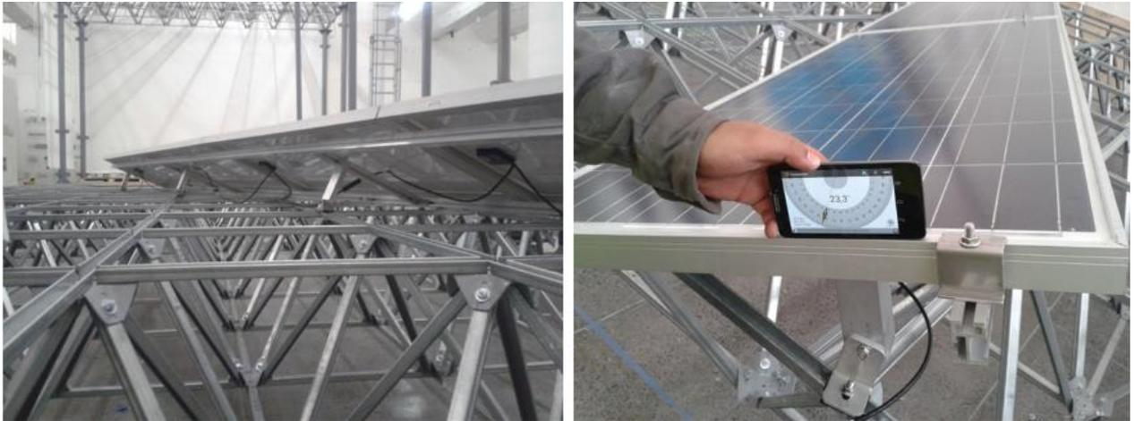
**Fig. 37** Interfaz bastidor – cubierta.
