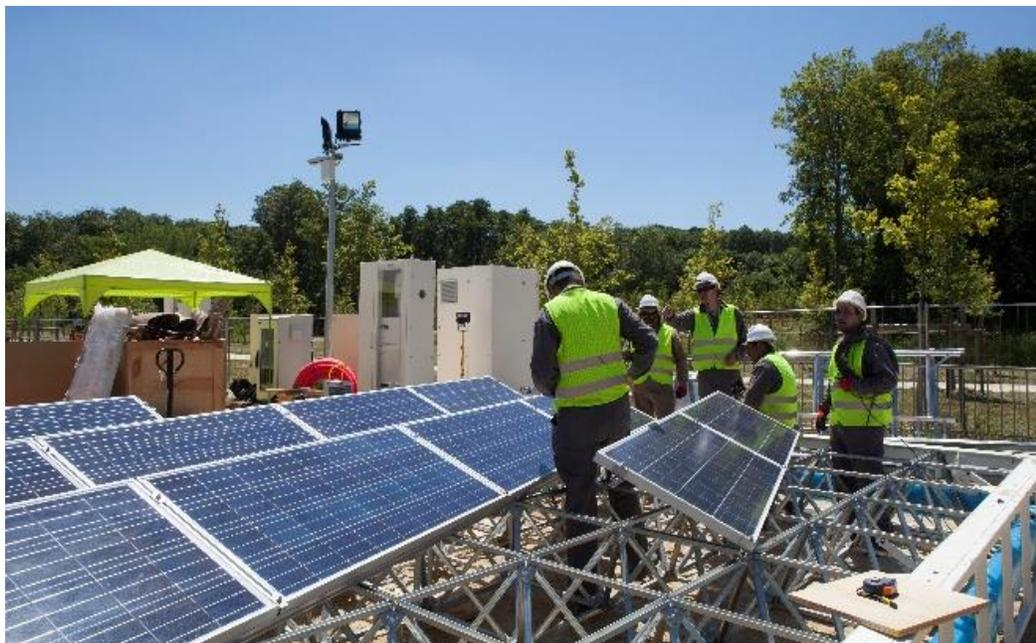
**Fig. 42** Instalación de bastidores sobre cubierta.
