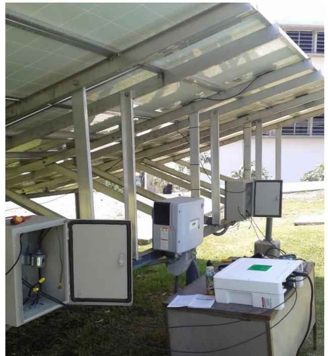
**Fig. 35** Instalación y prueba de inversor con arreglo fotovoltaico IER.
