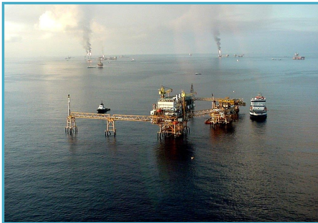
Figura 2.2. Vista panorámica de las plataformas en el Activo Integral Cantarell.
