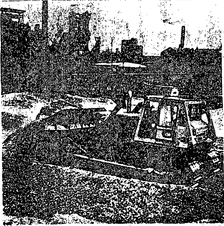
TENDIDO DE MATERIAL
