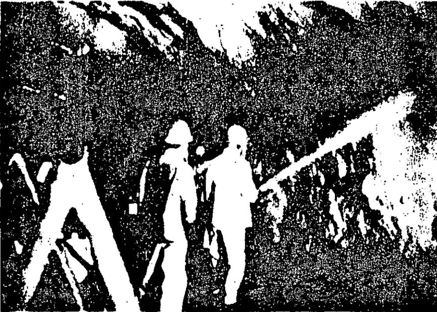
De primordial importancia es la constancia del aire, el agua y el flujo de materiales hacia la máquina lanzadora y a través de la boquilla de expulsión. No puede lograrse un buen concreto lanzado cuando el chorro varía en composición o tiene intermitencias.
