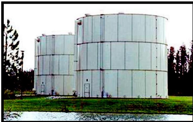
Figura 3. Tanque de almacenamiento de techo fijo.
