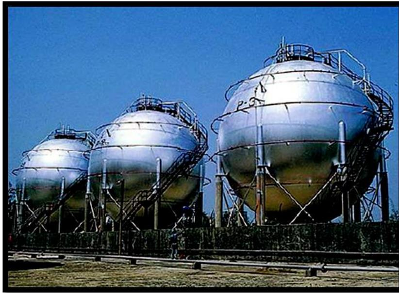
Figura 8. Tanque de almacenamiento esférico.
