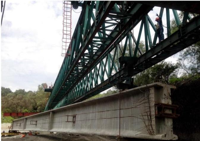
Lanzadora de traves. Se aprecia el "enviolinado" a base de torones tensados.
