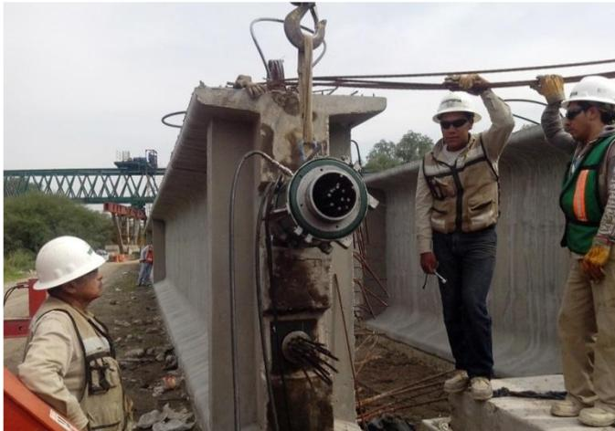
Foto 2.5 Construcción de puente Rio El Salto. Atotonilco, Hidalgo. Trabes postensadas tipo Nebraska
