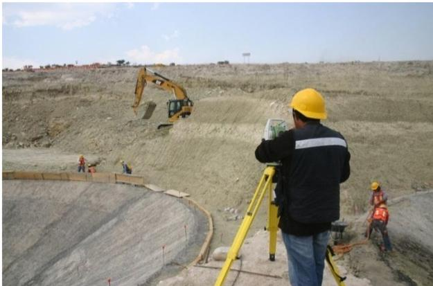
Foto 1.4 Construcción de la planta de tratamiento de agua residual. Atotonilco, Hidalgo. Plantilla de cimentación de biodigestor.
