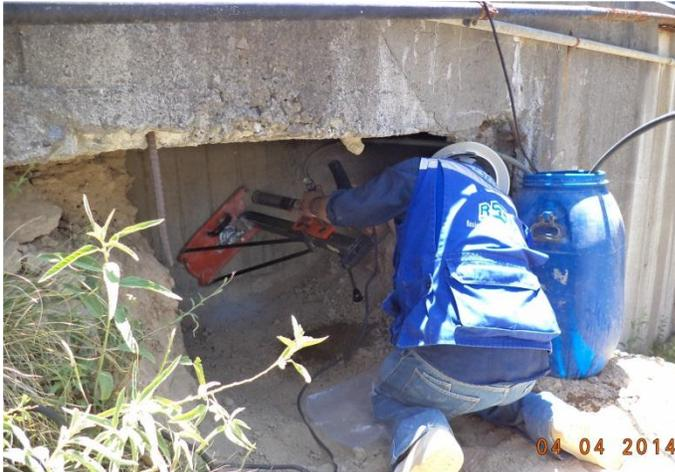
Foto 1.14 Construcción conexión del proyecto TEO con PTAR Atotonilco. Muro de canal de distribución.
