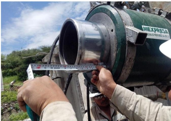
Foto 2.6 Construcción de puente Rio El Salto. Atotonilco, Hidalgo. Trabes postensadas tipo Nebraska
