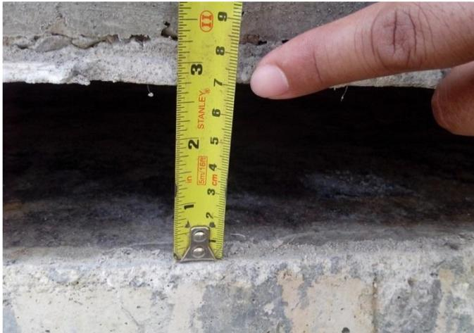
Flecha producida en un punto intermedio de la trabe NU, al aplicar el tensado.
