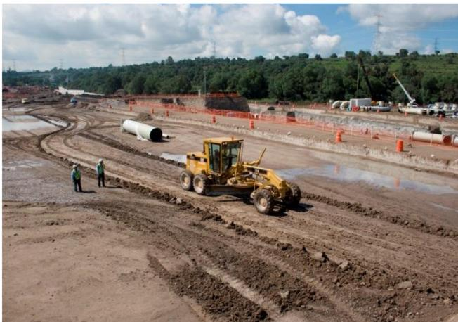
Despalme de terreno vegetal con motoconformadora.
