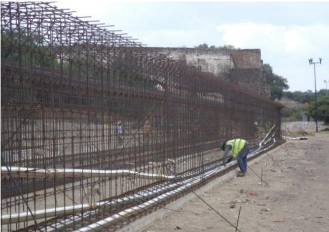
Foto 2.3 Construcción de puente Rio El Salto. Atotonilco, Hidalgo. Trabes postensadas tipo Nebraska.
