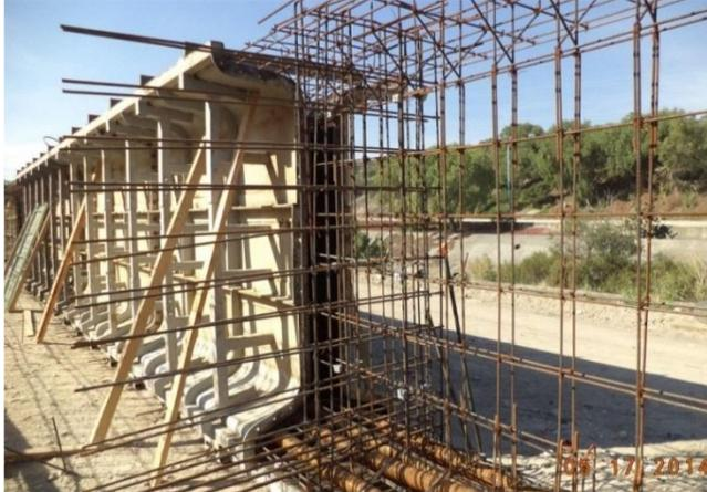
Foto 2.4. Construcción de puente Rio El Salto. Atotonilco, Hidalgo. Trabes postensadas tipo Nebraska
