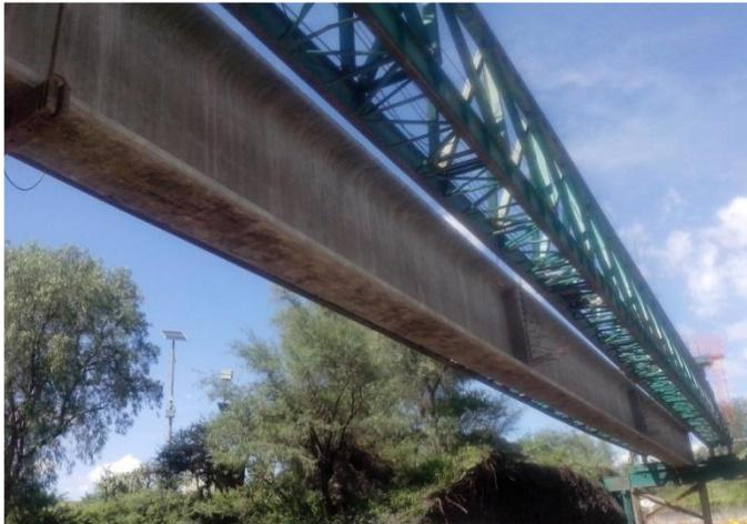
Foto 2.9 Construcción de puente Rio El Salto. Atotonilco, Hidalgo. Trabes postensadas tipo Nebraska
