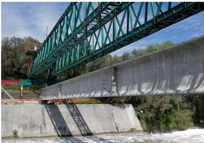
Foto 2.10 Construcción de puente Rio El Salto. Atotonilco, Hidalgo. Trabes postensadas tipo Nebraska
