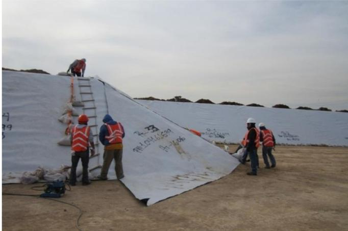
Colocación de geomembrana dentro de celdas de un relleno sanitario.
