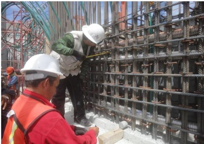
Inspección de armado de acero de refuerzo.
