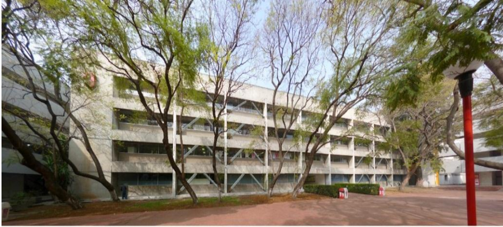
Figura 1.6. Proyecto de refuerzo estructural con contravientos restringidos contra pandeo del edificio G de la Universidad Autónoma Metropolitana Azcapotzalco, montaje fotográfico.
