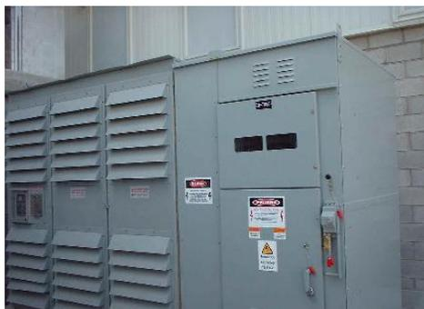
Figura 2.7 Subestación eléctrica tipo blindado [10].
