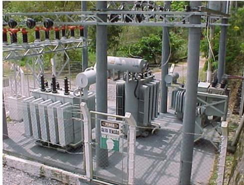
Figura 2.2 Subestación eléctrica elevadora [5].
