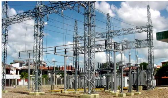
Figura 2.3 Subestación eléctrica reductora [6].
