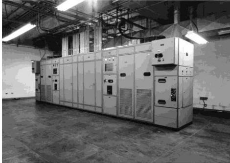
Figura 2.6 Subestación eléctrica tipo interior [9].
