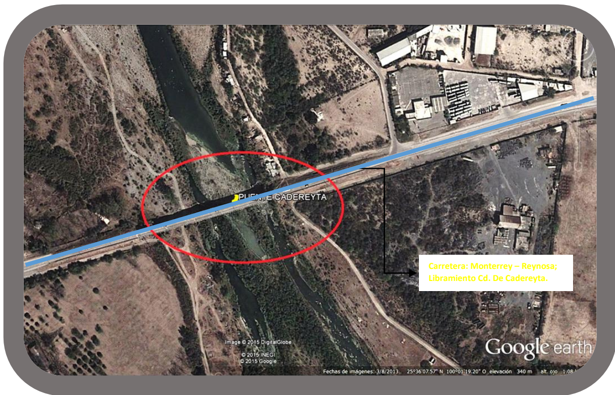
Figura 7: VISTA SATELITAL DEL PUENTE CADEREYTA.
