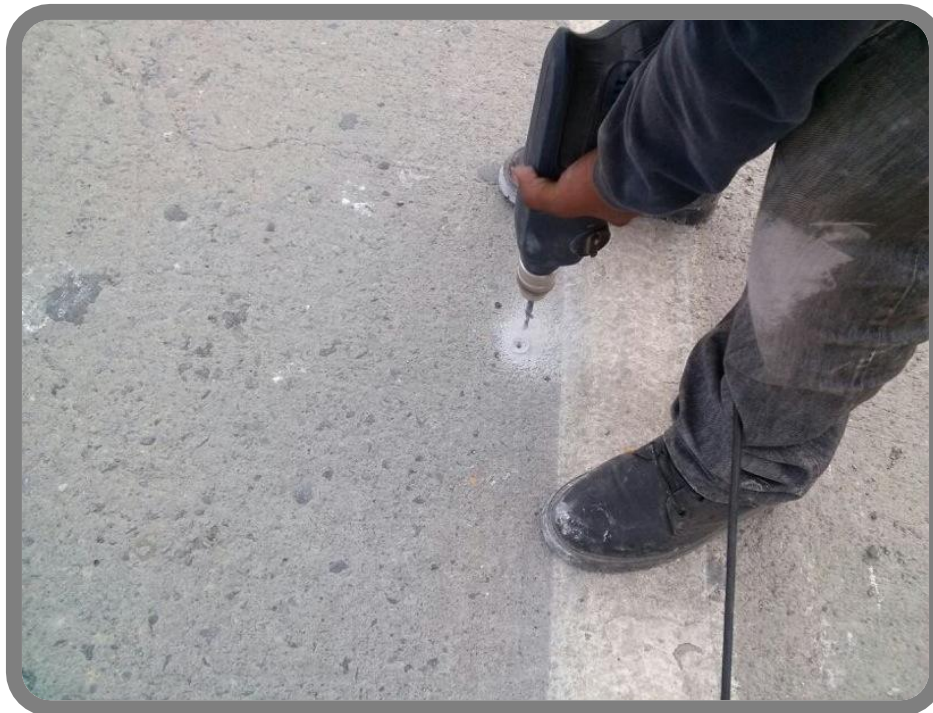
Figura 95: VISTA DE COLOCACIÓN DE TORNILLOS
