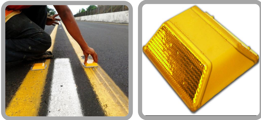
Figura 181: COLOCACIÓN Y EJEMPLO DE VIALETAS
