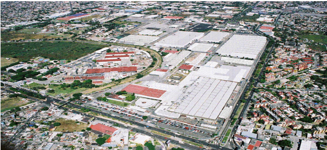
Fig. 1 Vista aérea del complejo industrial Planta Cuernavaca
