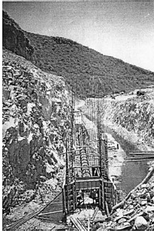
Figura 5.3 Fotografía de la trinchera de desvío para colocar el tubo de salida de aguas abajo (Flores et al. , 2010)
