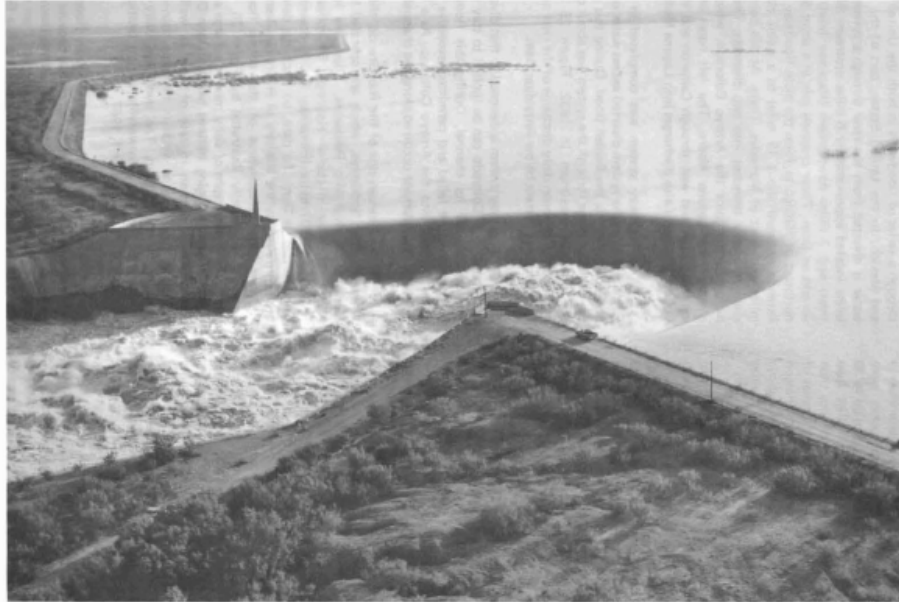
Figura A.3. Vista aérea de la presa Marte R. Gómez descargando aprox. 4\,250\text{ m}^3/\text{s} .
