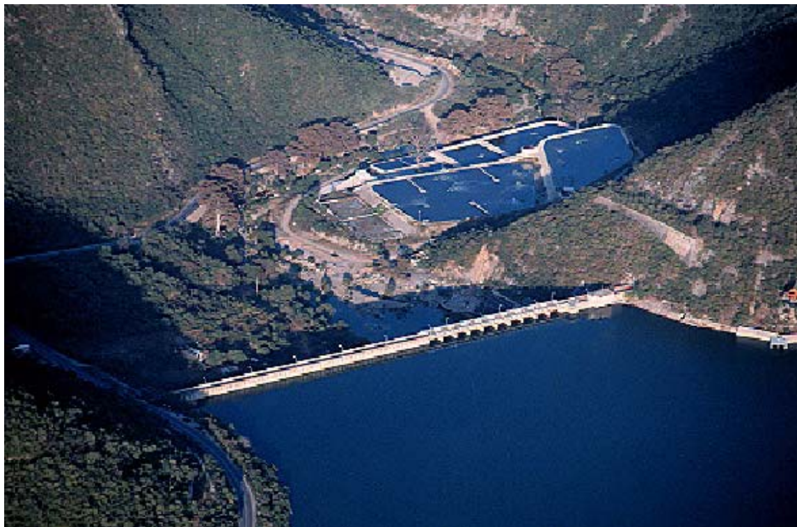
Figura 2.5. Obra de excedencias. Presa La Boca, N. L.
