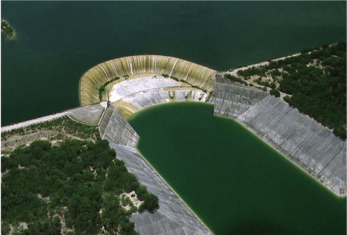
Figura 2.10. Obra de excedencias. Presa Marte R. Gómez, Tamps.
