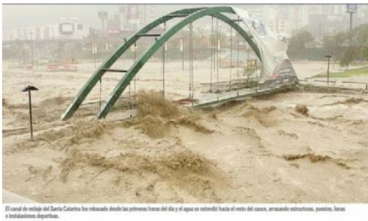
El canal de escape del Cerro Catarina fue rebasado desde las primeras horas del día y el agua se extendió hacia el resto del cauce, arrasando estructuras, puentes, botes e instalaciones deportivas.
