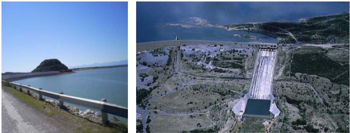
Figura 2.2. Presa Cerro Prieto.
