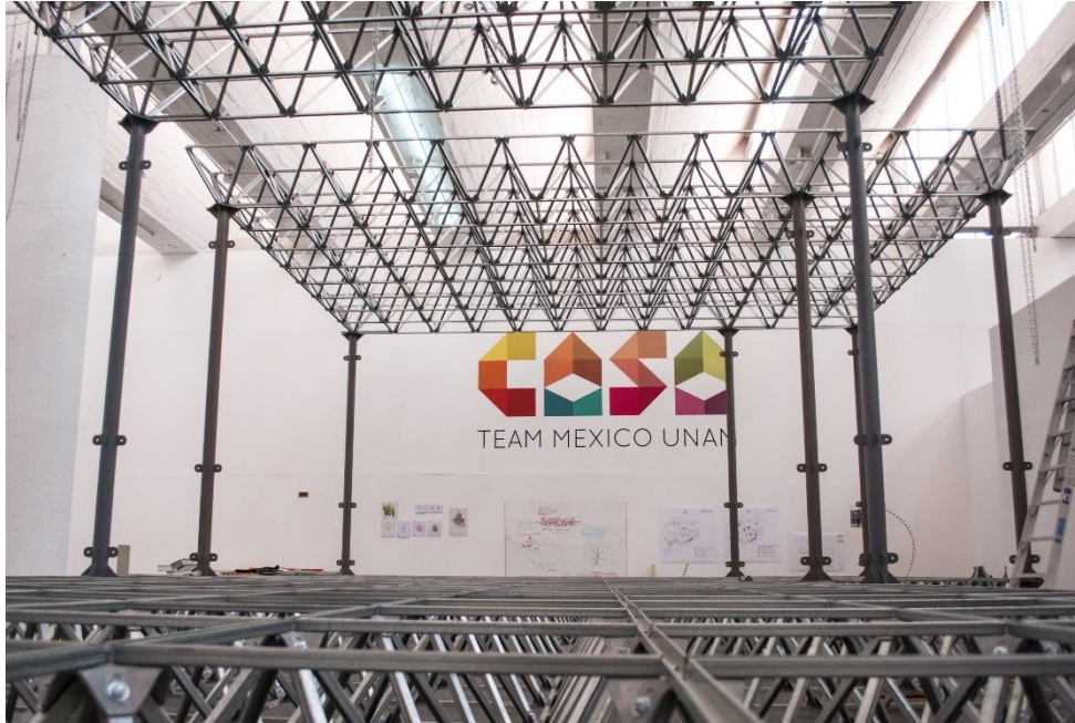
Figura 2.14. Estructura tridimensional del proyecto CASA UNAM en el MUCA C.U.
