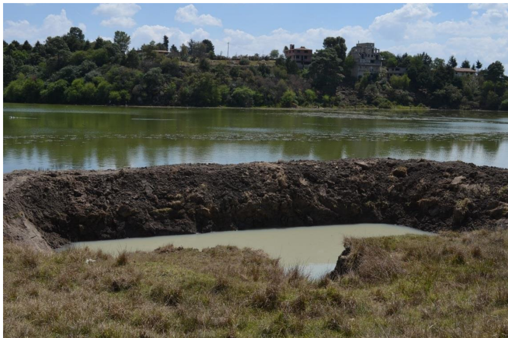
Figura 4.3. Tipo de fosa séptica que se encuentra en el embalse de Villa Victoria
