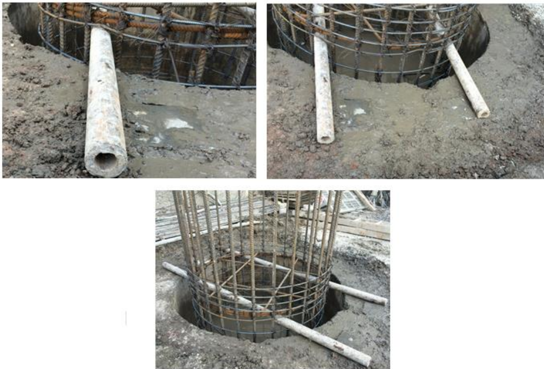
Fig. 3.27, Traqueo del Armado Inferior
