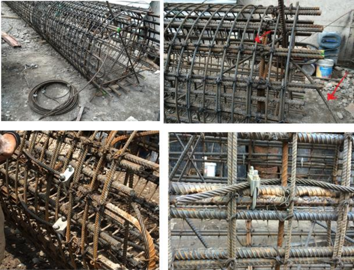
Fig. 3.20, Colocación de Estrobo para Trampeado Final
