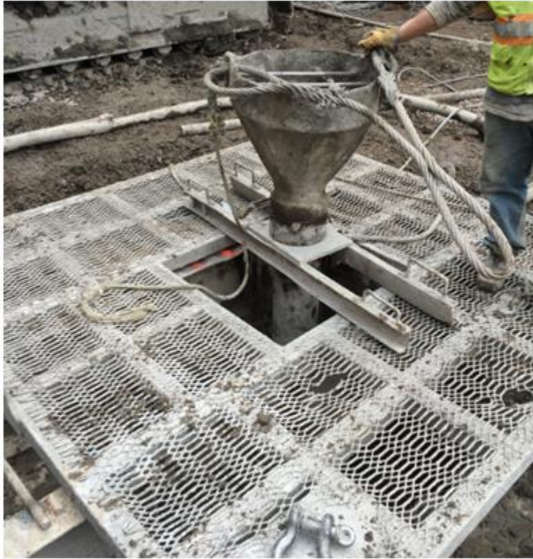
Fig. 4.14, Tubo Tremie armado listo para el colado
