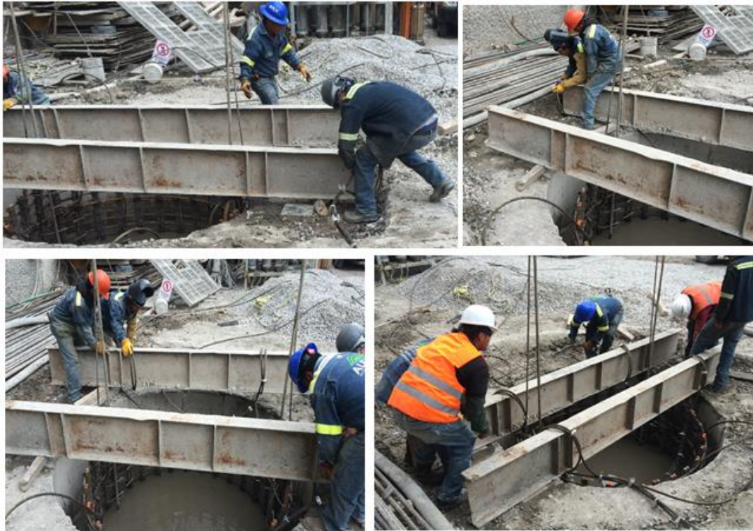
Fig. 3.37, Colocación de Estrobo en las Viguetas
