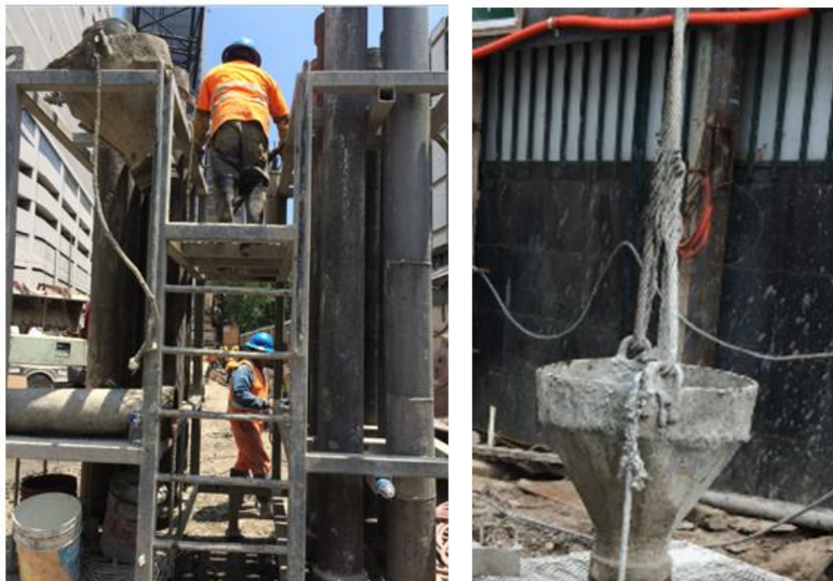
Fig. 4.9, Tolva, Conexión a la Grúa.
