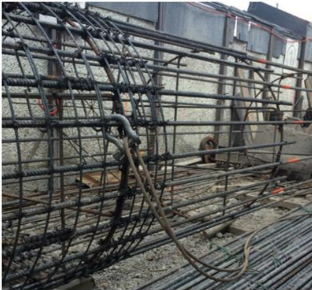
Fig. 3.13 y 3.14, Estrobos y Grilletes
