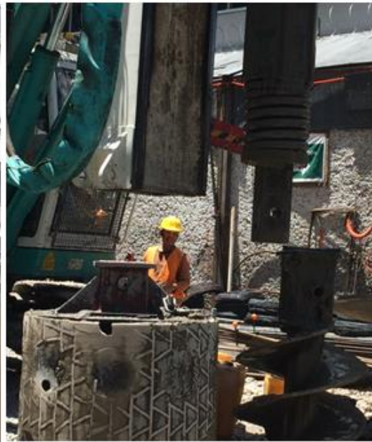
Fig. 2.34, Cambio de la Broca por el Bote
