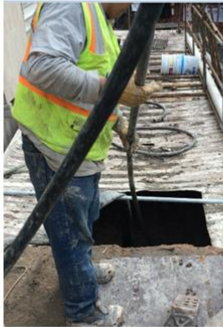
Fig. 2.23, Recirculación del Lodo
