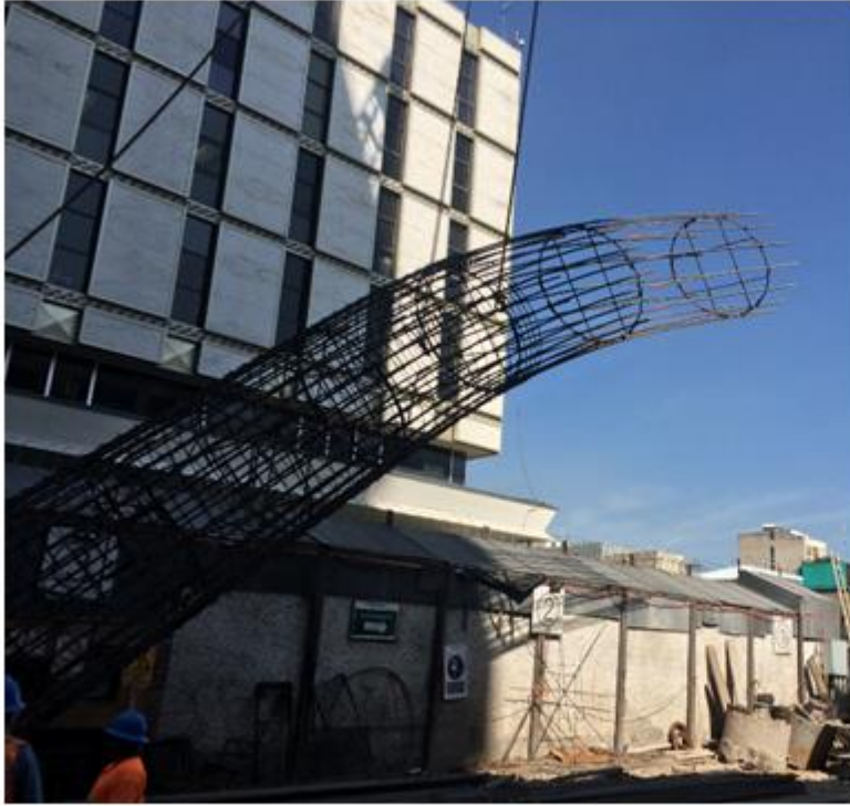
Fig. 3.22, Armado Izado
