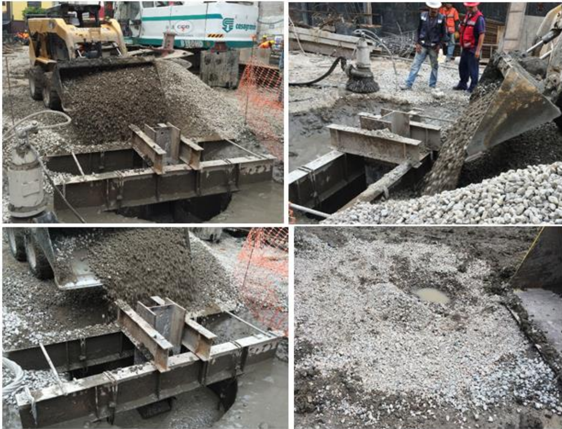
Fig. 4.27, Relleno de Perforación con Grava
