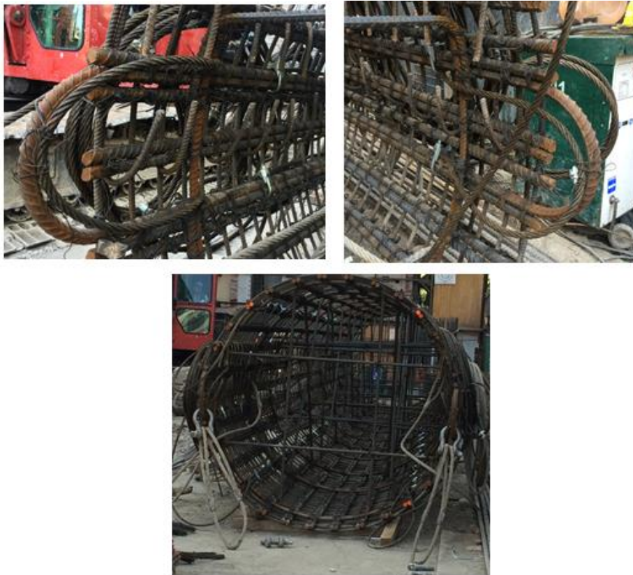
Fig. 3.26 Colocación de los grilletes y estribos a las orejas de izaje
