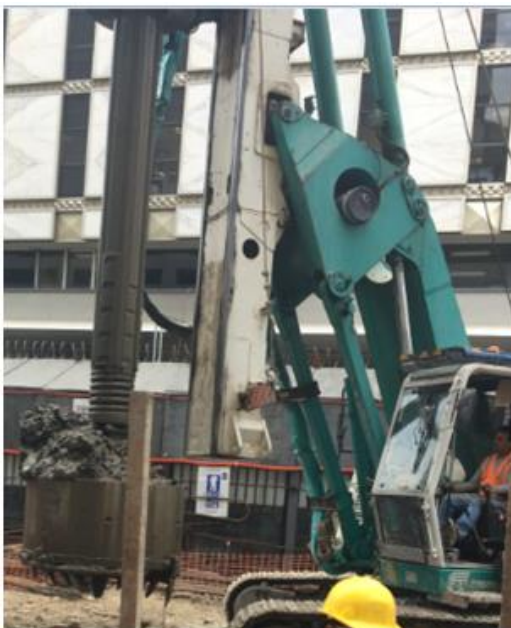
Fig. 2.33, Material Recogido por el Bote
