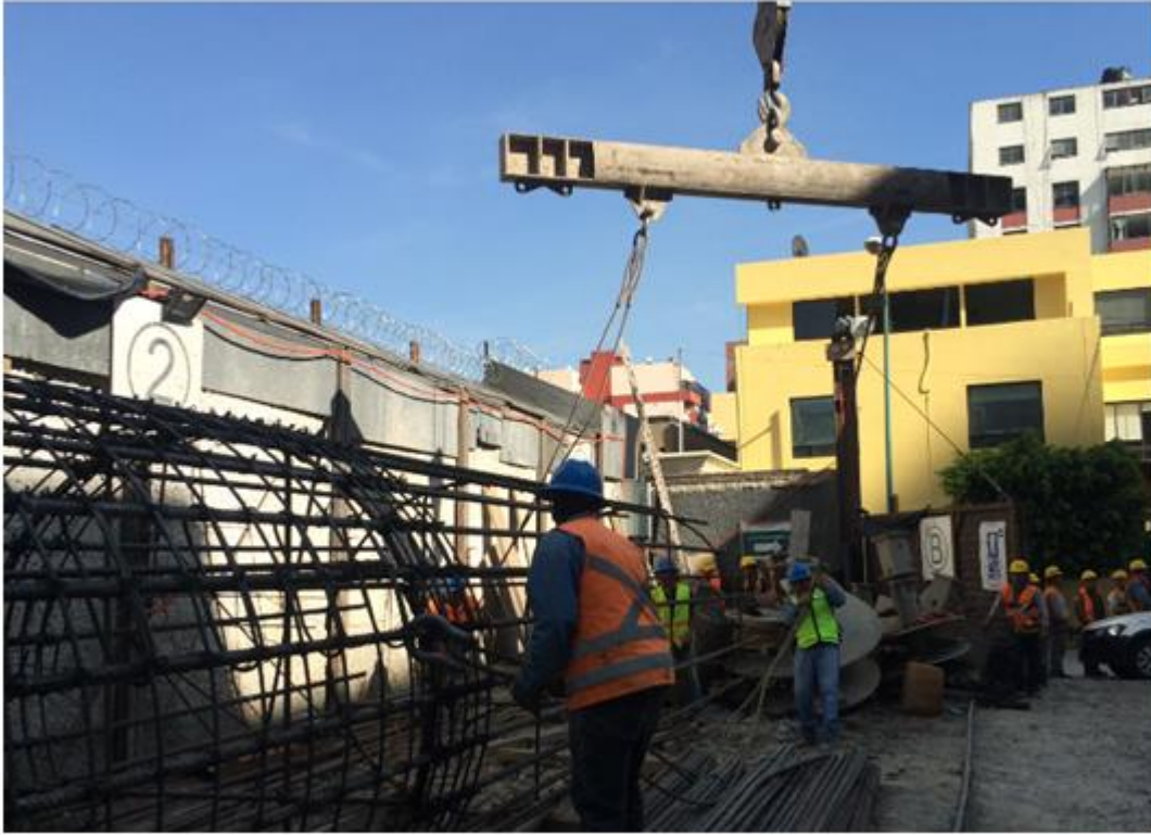
Fig. 3.15, Conexión Armado Inferior con el Balancín
