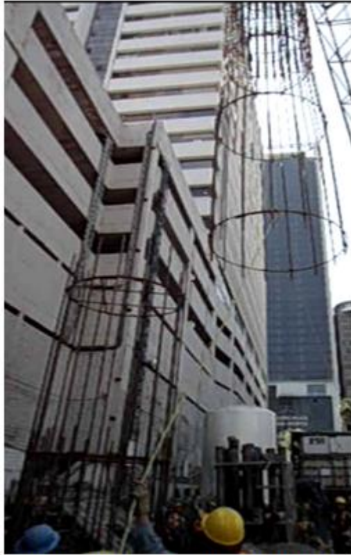
Fig. 3.12, Armado Inferior y Superior
