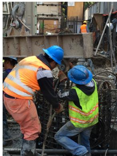
Fig. 3.34, Conexión de estrobos internos al balcón y Tensado
