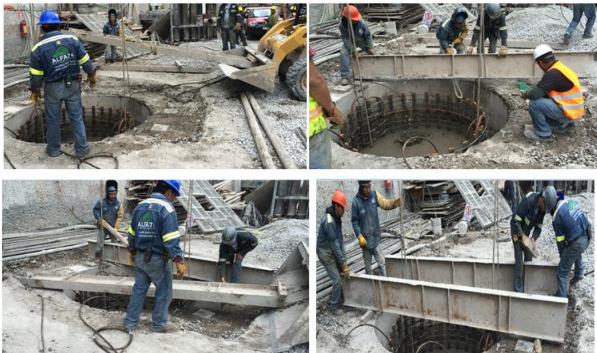
Fig. 3.36, Colocación de Viguetas Metálicas en Placas Metálicas del Brocal
