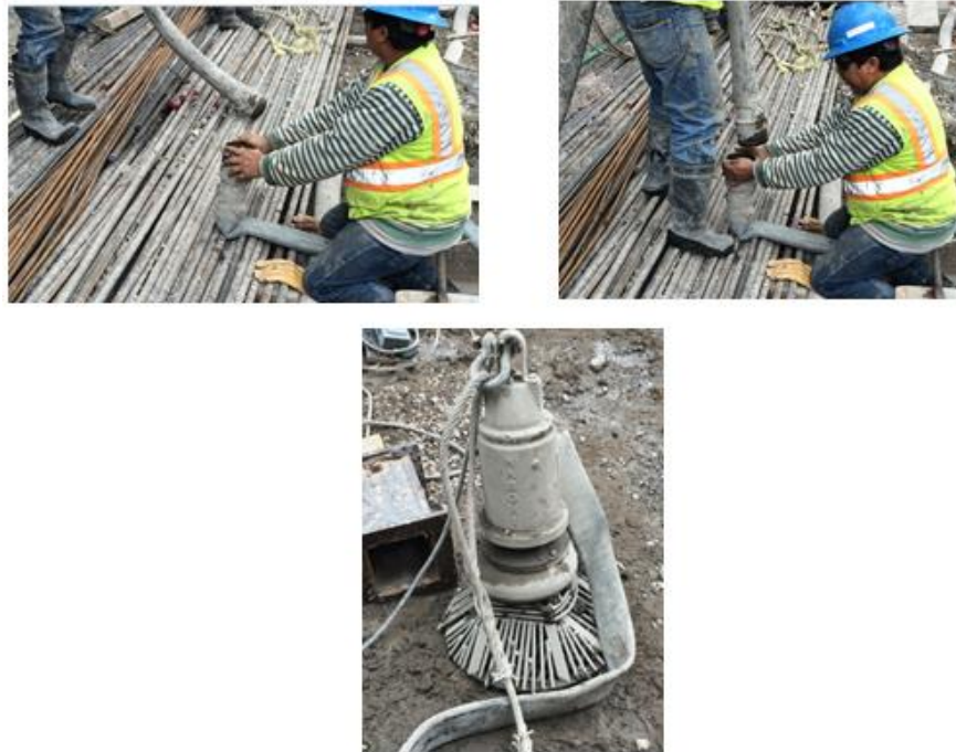
Fig. 4.8. Armado Sistema de Bombeo
