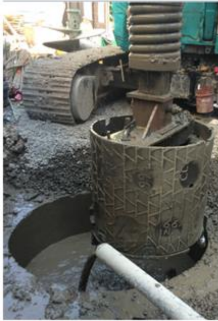
Fig. 2.31, Inicio de la Perforación Fig. 2.32, Material que se queda en la broca
