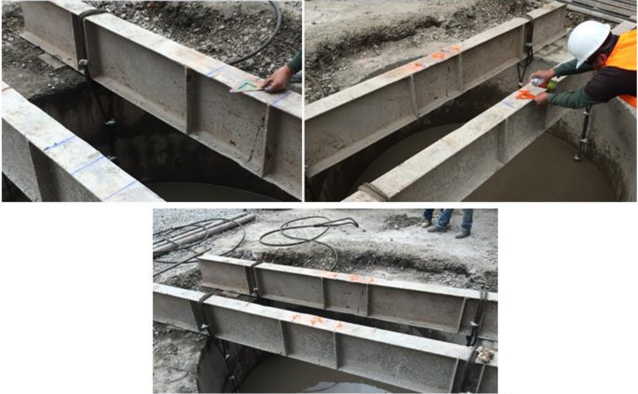
Fig. 3.41, Colocación de Marcas para Identificar la Posición del Puntal Metálico
