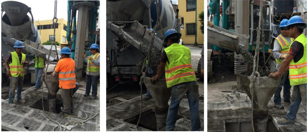
Fig. 4.18, Colocación de Concreto en Tubo Tremie
