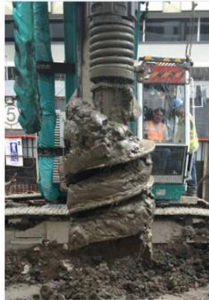
Fig. 2.31, Inicio de la Perforación Fig. 2.32, Material que se queda en la broca
