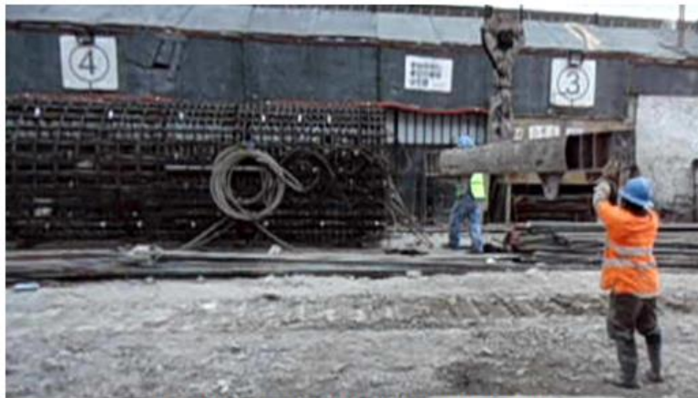
Fig. 3.28, Conexión del Balancín al Armado Superior
