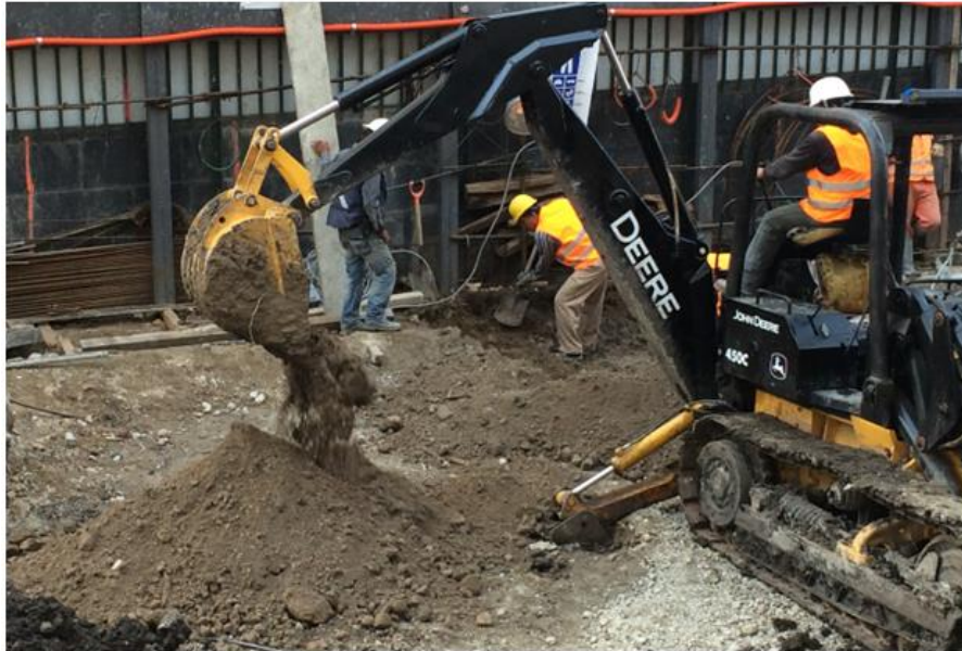
Fig. 1.28, Destape del Brocal
