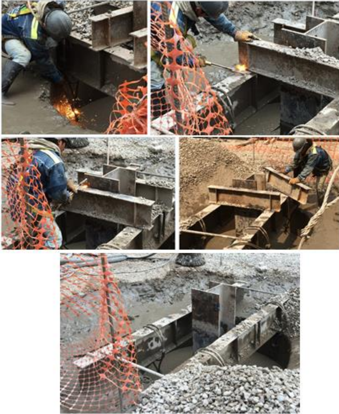
Fig. 4.25, Corte Estrobo y Corte de Cordones de Soldadura
