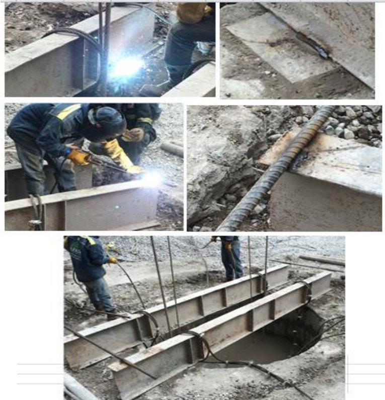
Fig. 3.40, Soldado de Viguetas y Varillas
