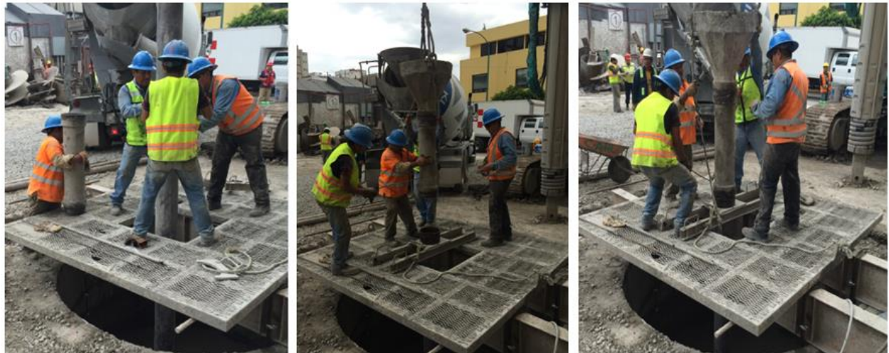
Fig. 4.13, Colocación del último tramo de la tubería tremie
