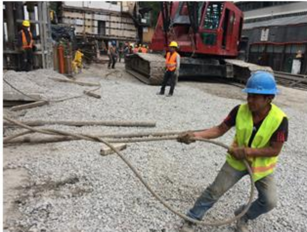
Fig. 3.33, Desenredo de Estrobos
