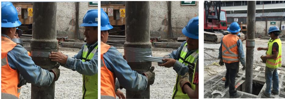
Fig. 4.11, Colocación de Cinta Gafferr
