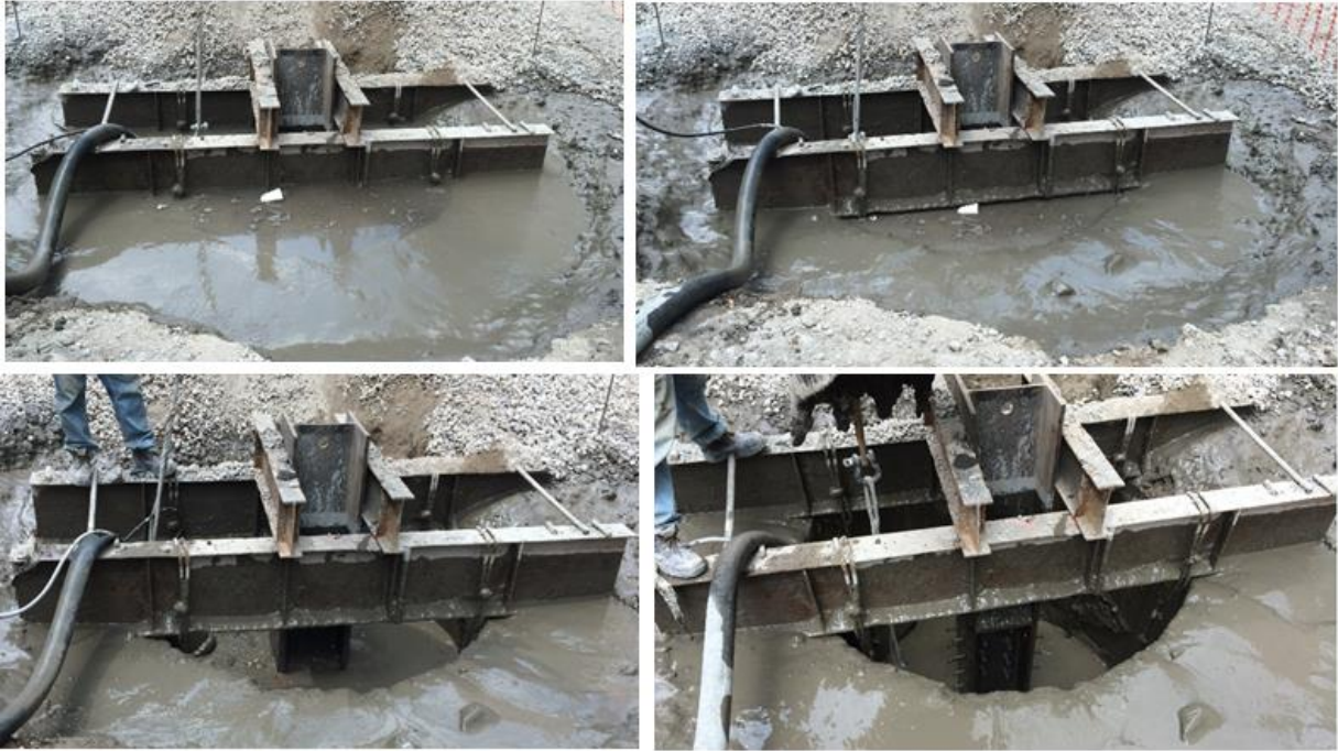
Fig. 4.26, Bombeo Exceso Lodo Bentonítico
