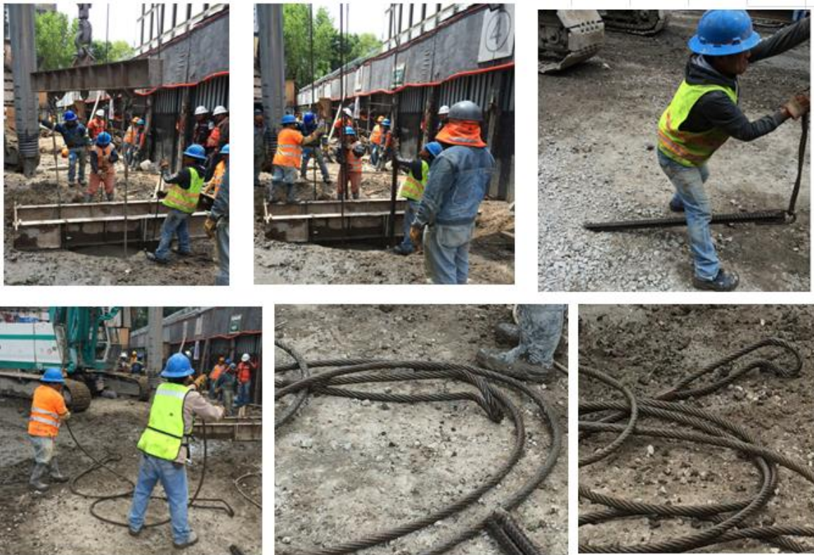
Fig. 3.38, Sacando Estrobo Internos y Agujas
