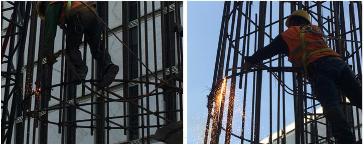
Fig. 3.31, Corte de Refuerzos Provisionales
