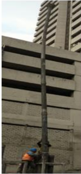
Fig. 4.10, Chicote, Armado Tubería Tremie
