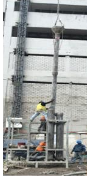
Fig. 4.10, Chicote, Armado Tubería Tremie
