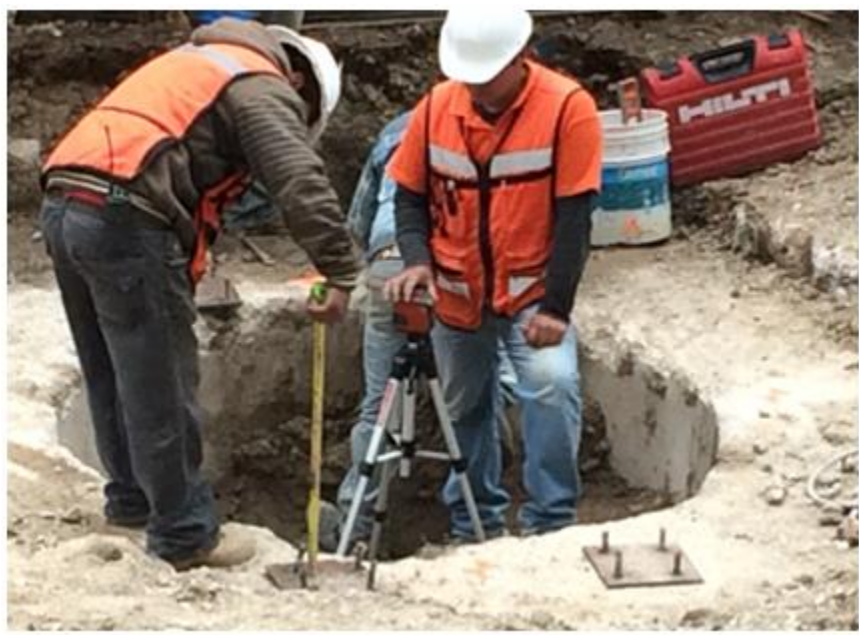
Fig. 1.27.1, Nivelación de las Placas de Apoyo
