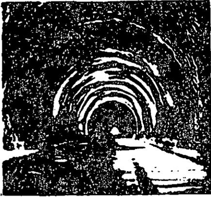
*Fig.153 CONCRETO LANZADO*
