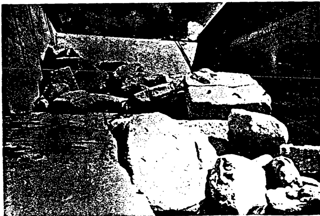
**Fig 1.24** Presa Netzahualcóyotl. Losas del tanque amortiguador desplazadas hacia aguas abajo
