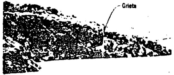
Fig 4.5 Grieta en el vaso de la presa Huichapan, Hgo.
