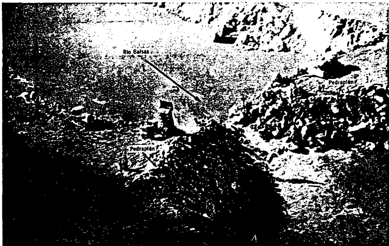
Fig 1.4 Desviación del río Balsas en El Infiernillo
