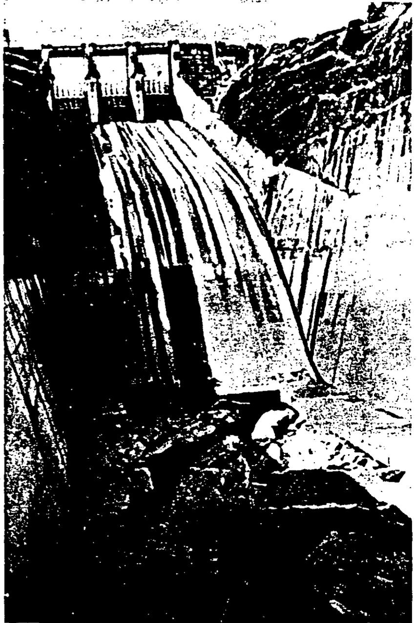
Fig 1.23 Presa Netzahualcōyotl. Vertedor de operación mostrando la parte dañada del tanque amortiguador
