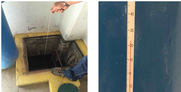
Figura 43 Lecturas de temperaturas del agua almacenada en la cisterna del laboratorio
