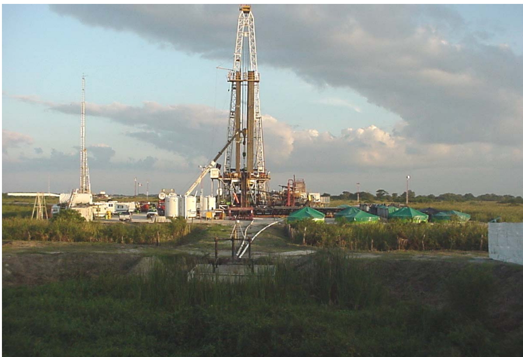
Instalaciones de un equipo de perforación terrestre
