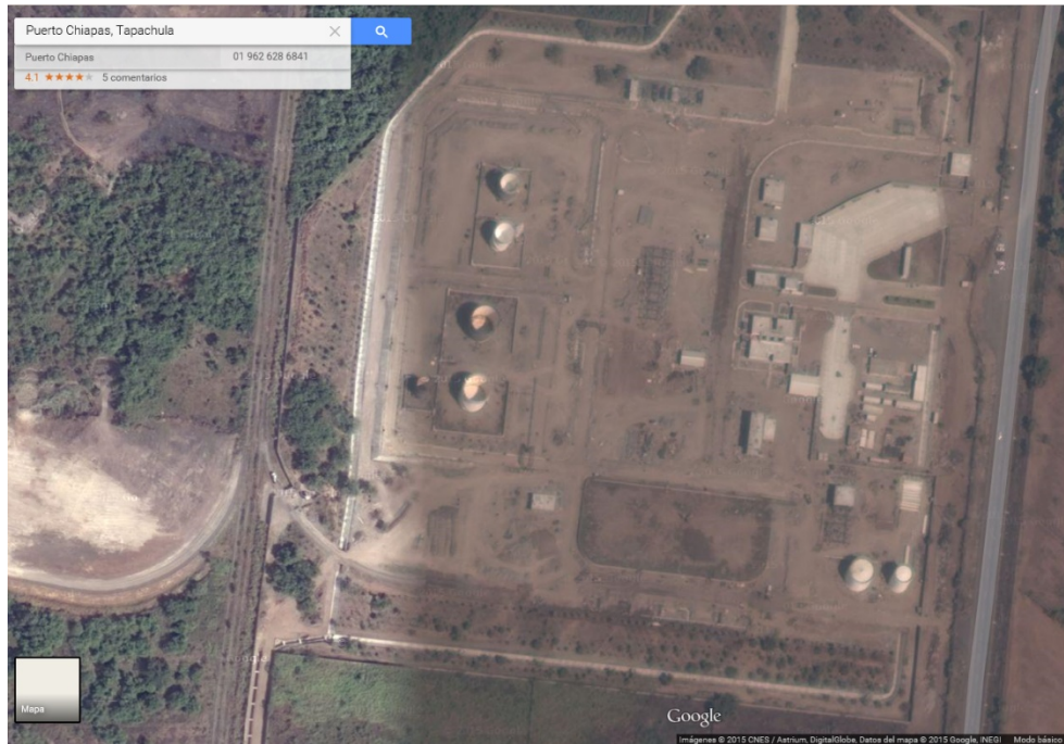
Figura 1. Terreno sobre el que se construye la nueva TAR. En la imagen se puede ver que han iniciado los trabajos de construcción de los tanques y de las oficinas administrativas.
