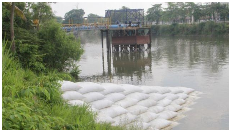
Figura 2.3.2 Espigones hechos con bolsacreto (Descargado de: http://www.tabascohoy.com/ ).
