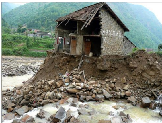
Figura 2.4.1 Figura 2.4.1 Los restos de una casa que se derrumbó que se encontraba a la orilla del río en la ciudad de Wangmo ( http://www.boston.com ).
