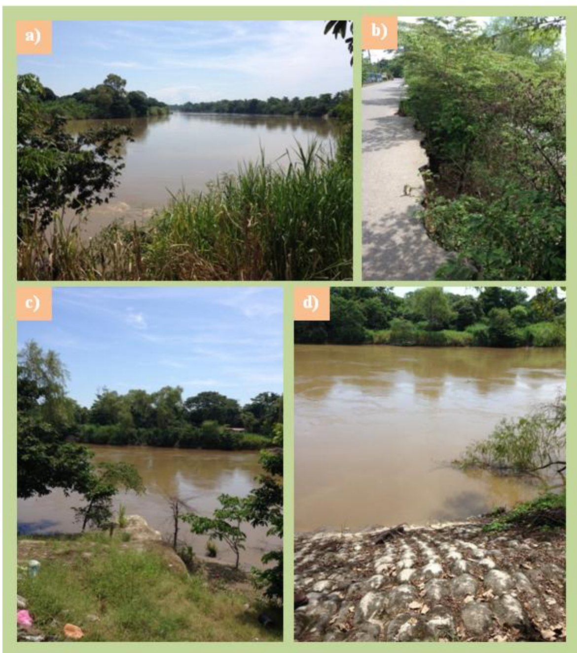
Figura 3.3.3 Fotografías de la zona de estudio. (a) Rivera del río; (b) Margen afectada por el proceso erosivo; (c) Espigón existente; (d) Espigón existente.
