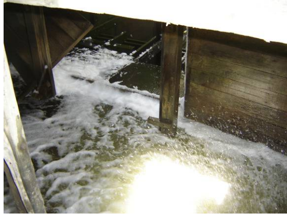
Figura 2.16 Falta pared de la tina de agua caliente.
