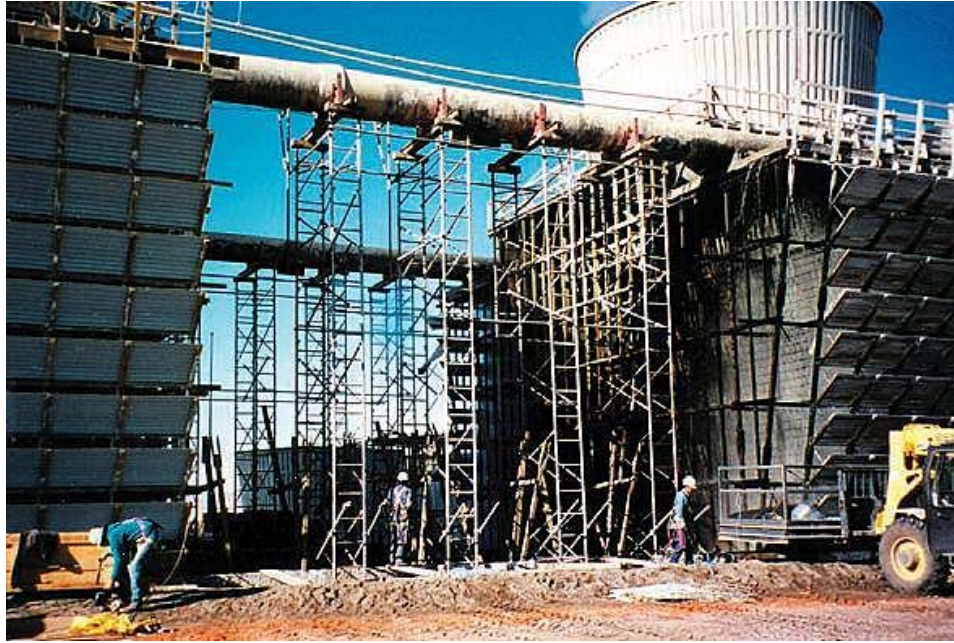
Fig. 1.16 Torre montada en campo.
