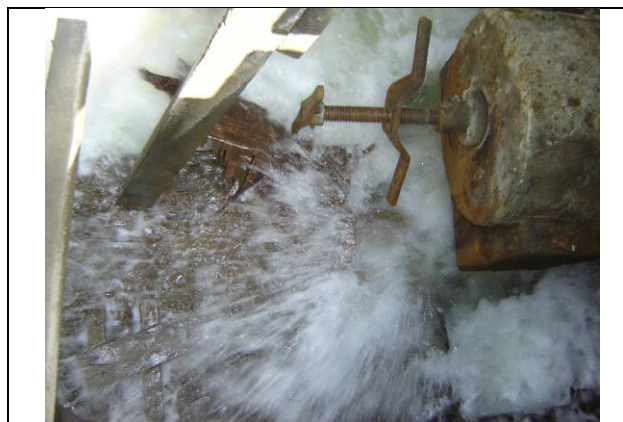
Figura 2.9 Caja de distribución inadecuada
