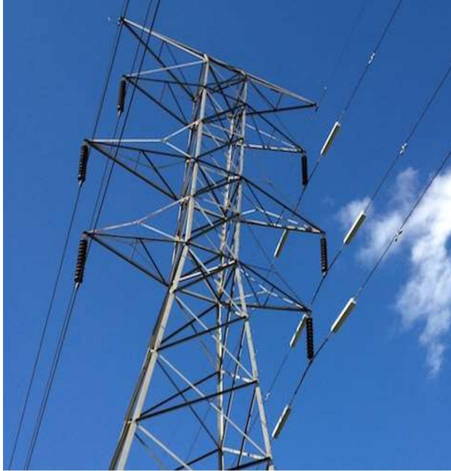
Figura 3.2. D-FACTS en líneas de transmisión real.
