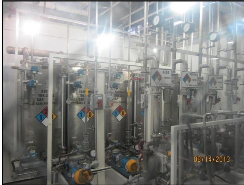
**Figura 2.15** Tanques de almacenamiento de perfumes.
