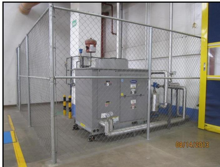
**Figura 2.25** Sistema chiller de aire acondicionado.
