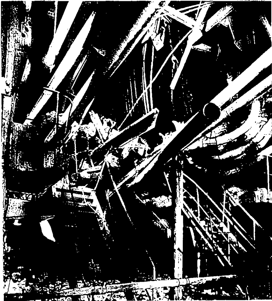
Un agrietamiento en la tubería causó la destrucción total de esta caldera de radiación de tubos verticales.
