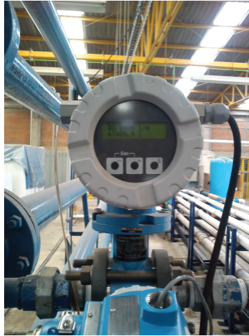
Figura 2.5: Sensor de flujo Promag 10D
