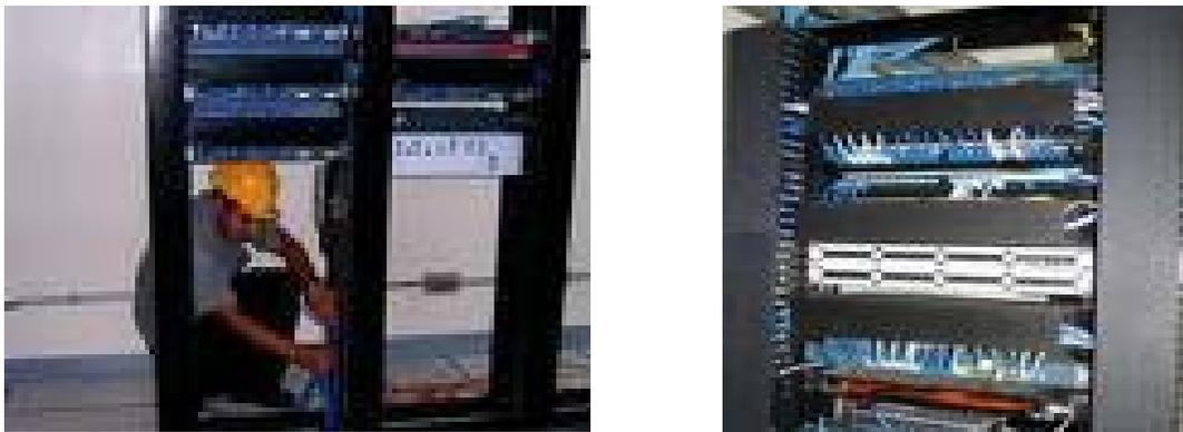
Figura 43 Colocación de los Patch Cord en los Switch
