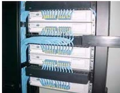
Figura 42 Instalación de los switches
