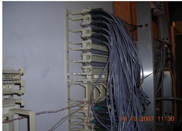
Figura 30 Cableado Estructurado Mal Organizado
