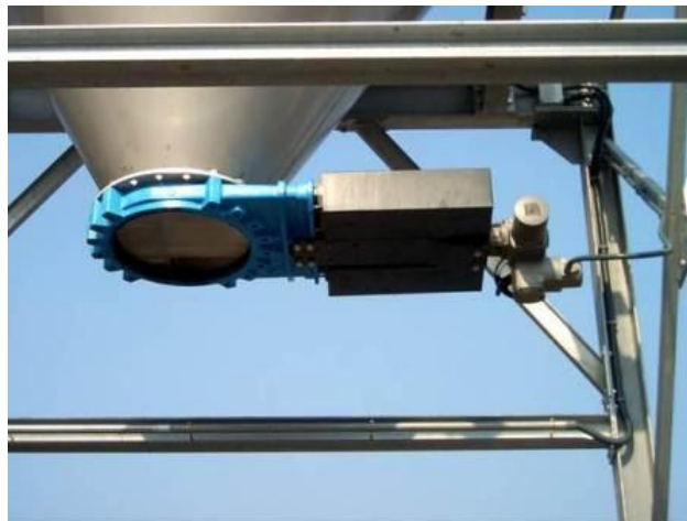
5 Figura 3. Válvula reguladora de suministro en los silos
