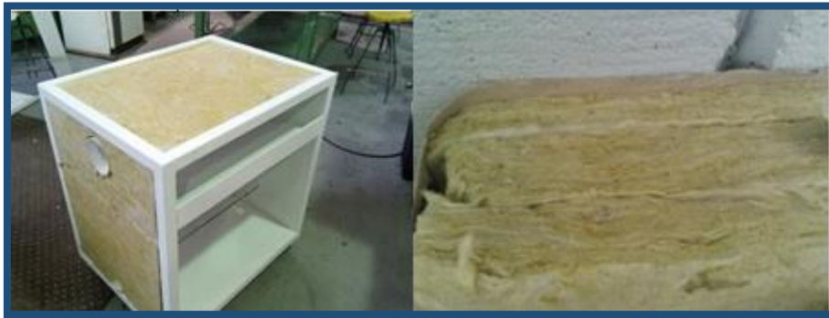
Figura 44. Colocación de las placas de fibra mineral.
