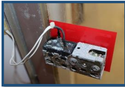
Figura 9. Control de Humedad.
