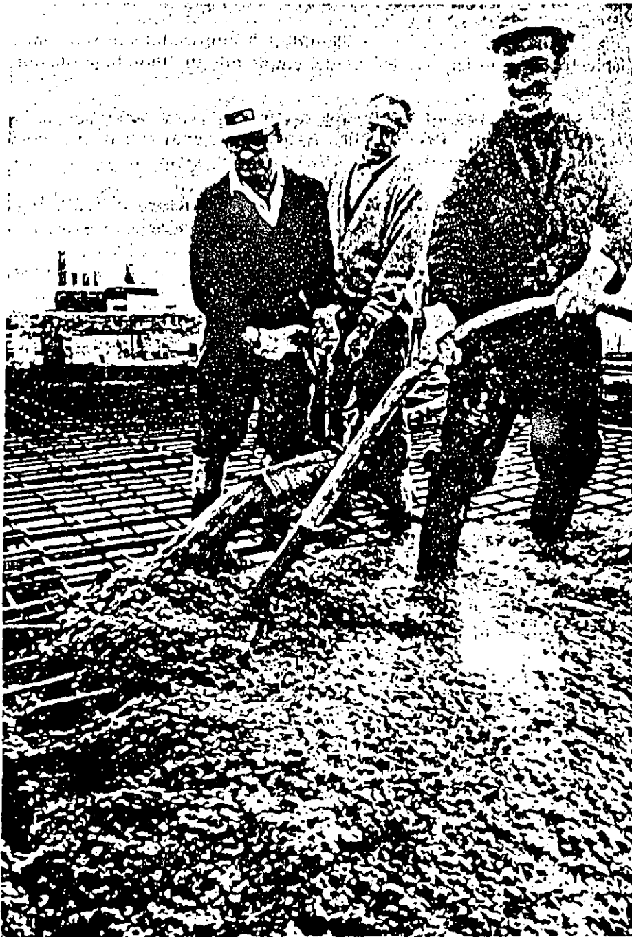
Fig. 11. Colado y vibrado de concreto bombeado en una losa suspendida para piso.
