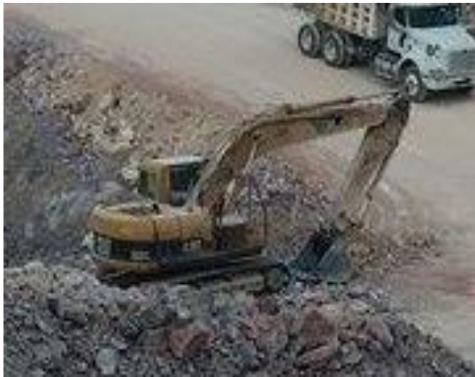
Figura 1.7 Excavadora. Equipo Rentado
