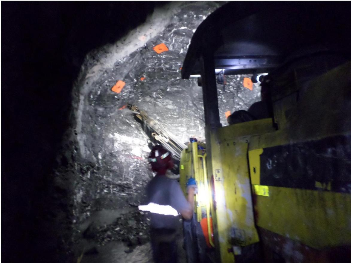
*Fig. 11. Barrenación con jumbo electro-hidráulico en mina Candelaria.*
