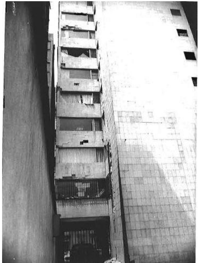
Figura C.15 "79m-A8" – Edificio de 13 niveles con daños en muros. (Meli, 1979)
