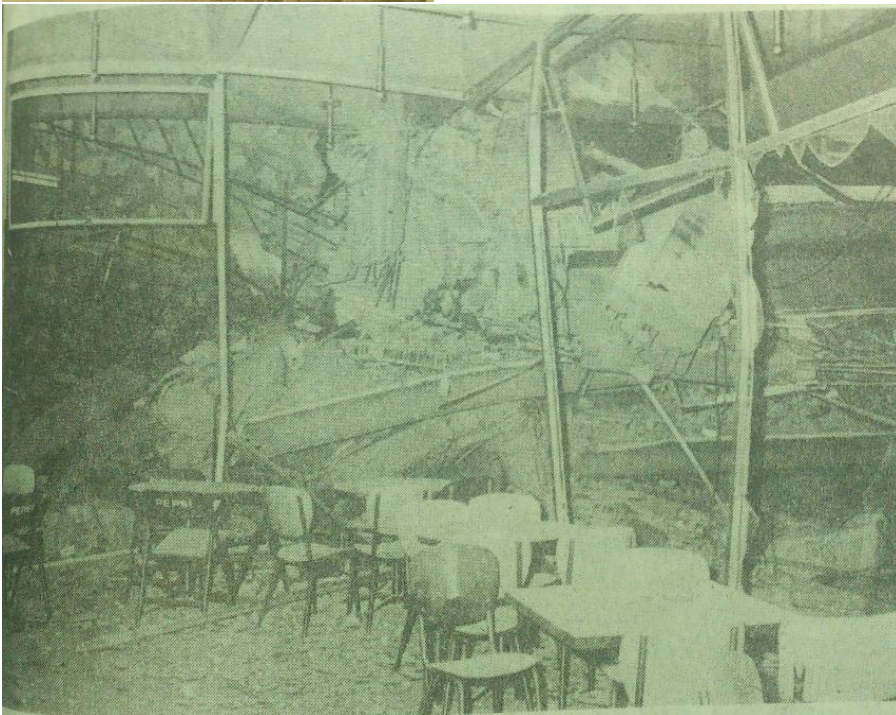
Figura C.12 a) El edificio Banca Cremi sufrió asentamiento grande que la abertura entre el edificio adjunto es muy notoria; b) Escuela que sufrió derrumbe en uno de sus costados (Excelsior, 1979)
