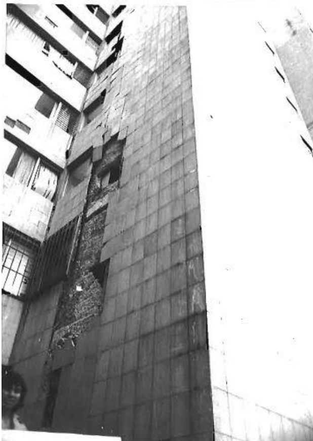
Figura C.15 "79m-A8" – Edificio de 13 niveles con daños en muros. (Meli, 1979)
