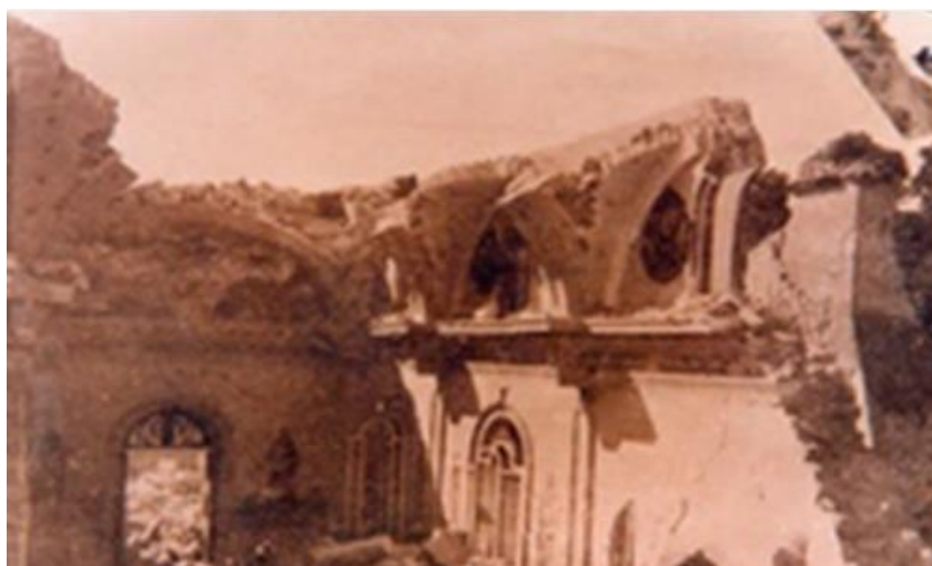
Figura 1.2 Iglesia de Acambay destruida por el sismo (ERN, 2012)
