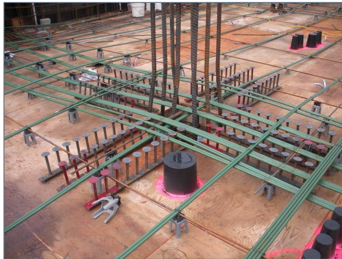
Figura III.1 Refuerzo de pernos sobre columna en losa postensada
