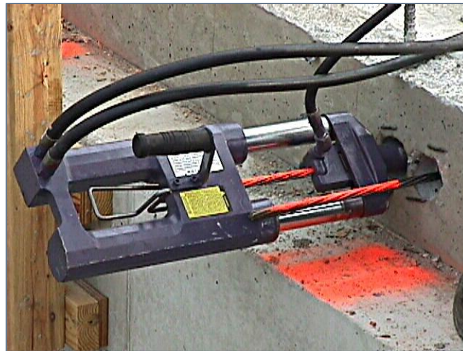
Figura I.20 Gato hidráulico empleado para tensar los tendones
