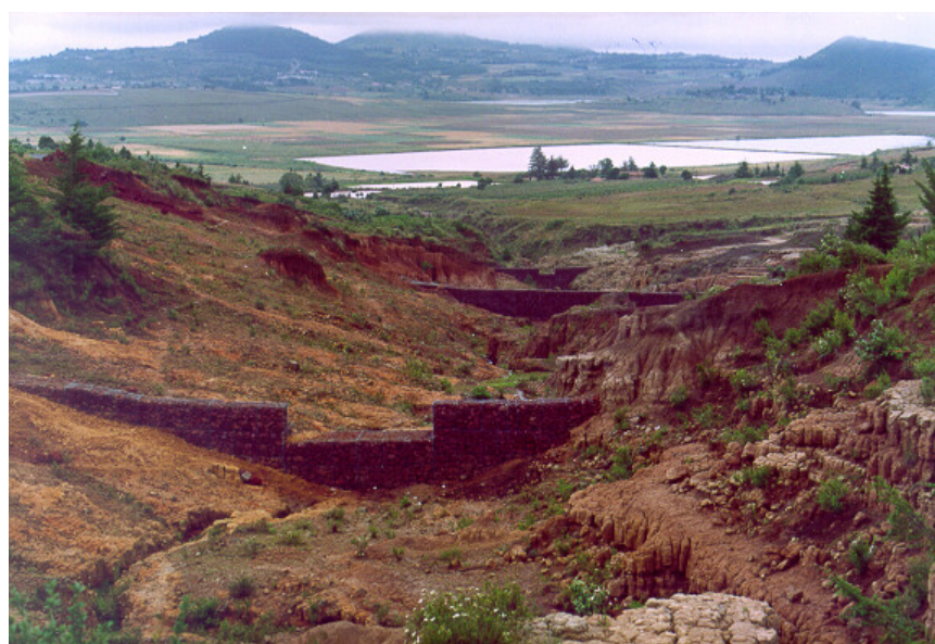
Figura 41 Represas Filtrantes de Gaviones y Mampostería
