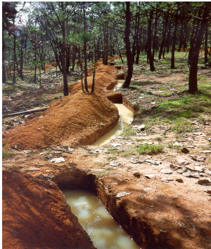
Figura 40 Zanjas Trinchera
