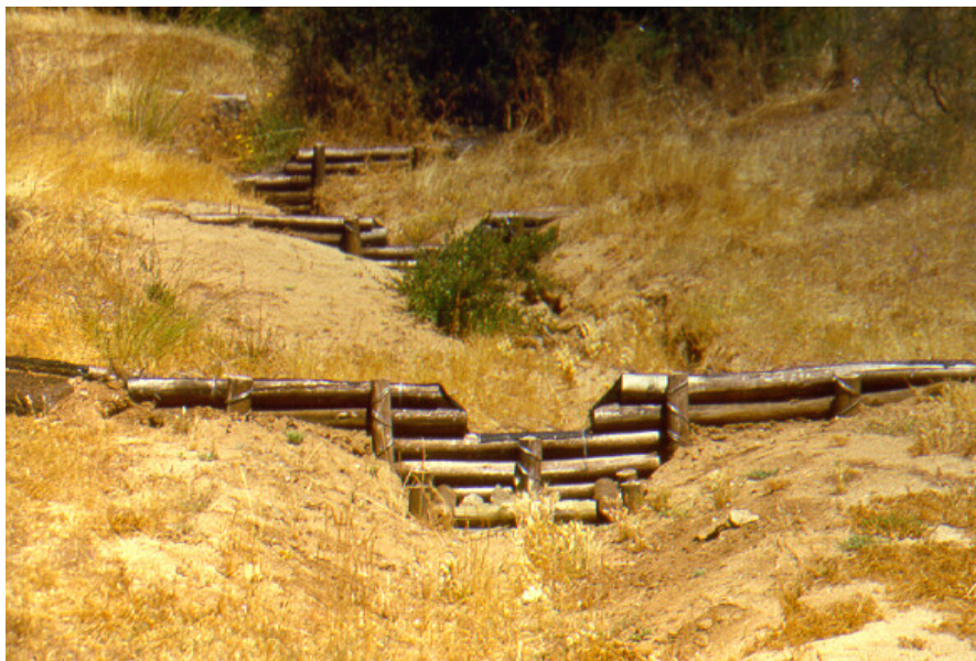
Figura 39 Represas filtrantes de piedra acomodada
