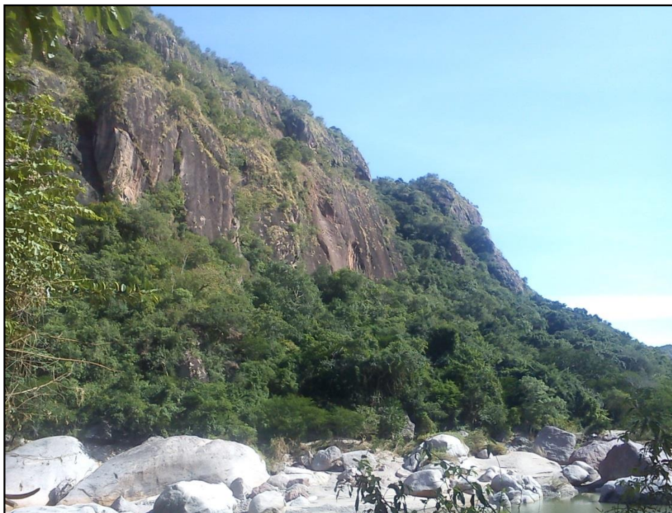
Fotografía 2.4 Falla El Cantil en la ladera de la margen izquierda.
