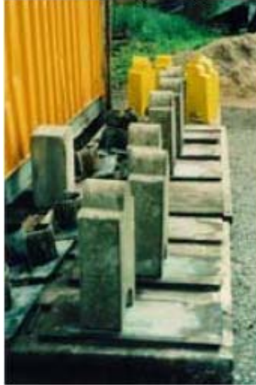
Claustro (bloque de hormigón).
