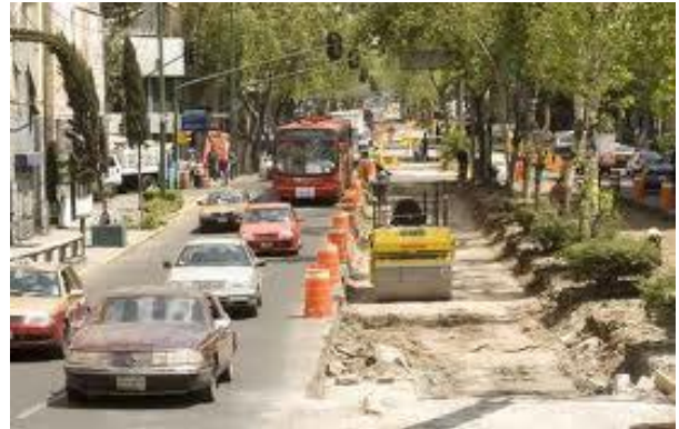
Imagen 3.3.5 Sustitución de la carpeta asfáltica por concreto hidráulico en Av. Insurgentes
