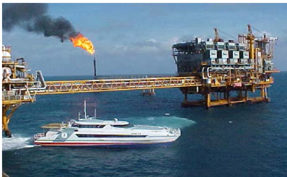
Figura 9. Plataforma de Compresión de Gas.
