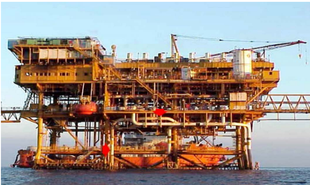
Figura 8. Plataforma de Rebombeo.
