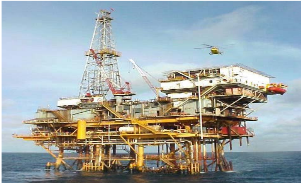
Figura 4. Plataforma de Perforación.
