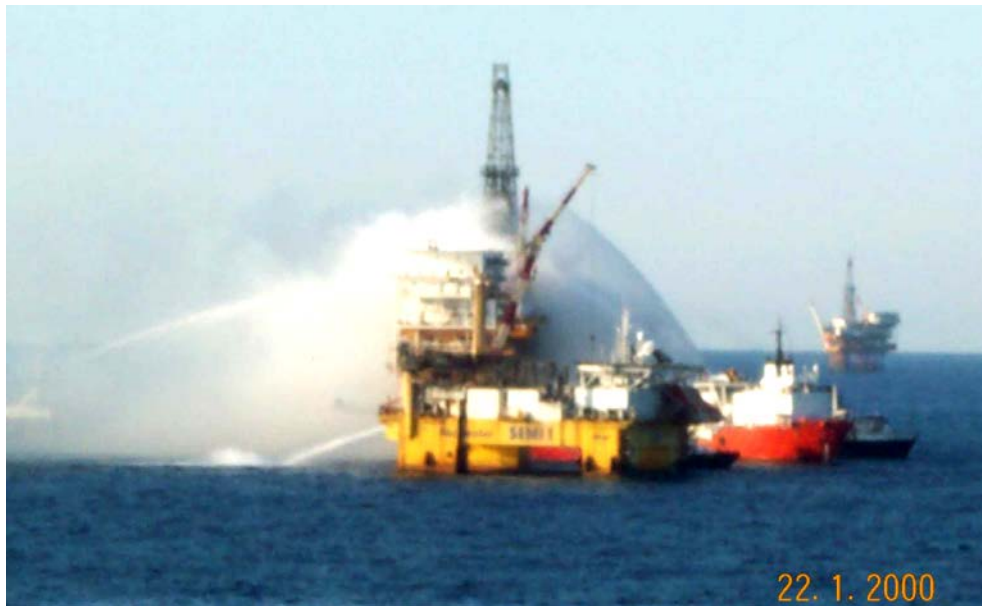
Figura 10. Plataforma de Inyección de Agua.
