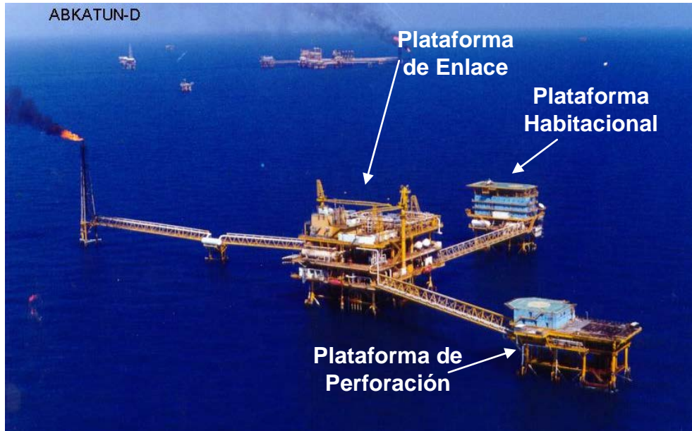
Figura 6. Plataforma de Enlace.
