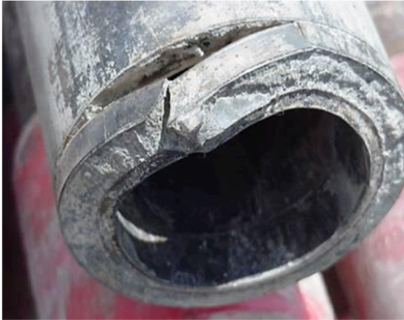
Figura 9 Corrosión por H 2 S en tubería de producción
