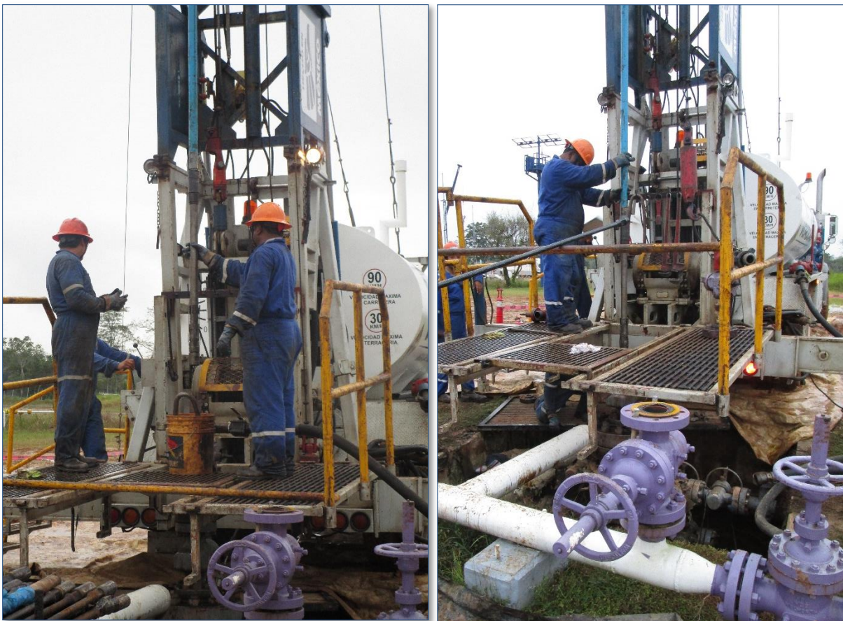
Figura 4.20 Prueba de Integridad para válvula viajera y de pie
