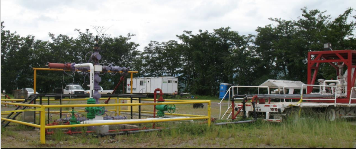
Figura 1.12 Instalación superficial del Bombeo hidráulico
