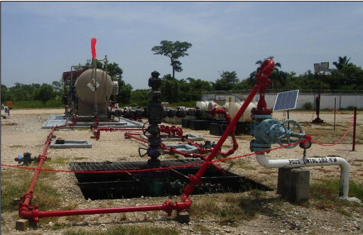
Figura 1.18 Compresor a boca de pozo (Gas jack)
