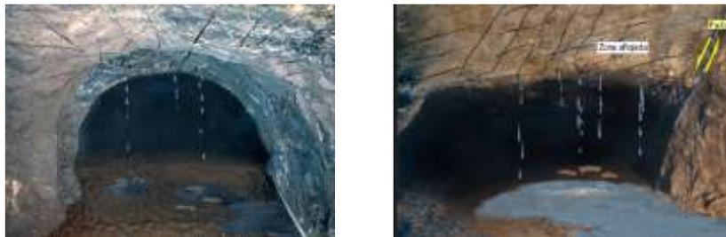
Imagen 61 Riesgo de desprendimientos de bloques por flujo de agua en el macizo rocoso. [9]
