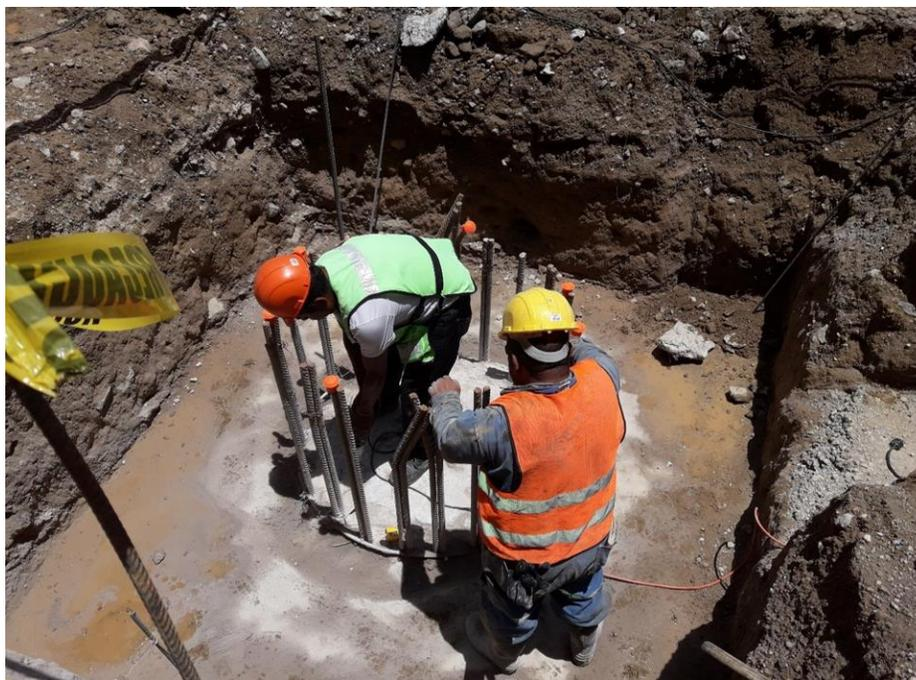
**FIGURA 3 PREPARANDO LA PILA 19D PARA FIJAR LOS GEÓFONOS Y REALIZAR LAS PRUEBAS MICROSÍSMICAS EN LA ETAPA 1 DEL PROYECTO INMOBILIARIO.**
