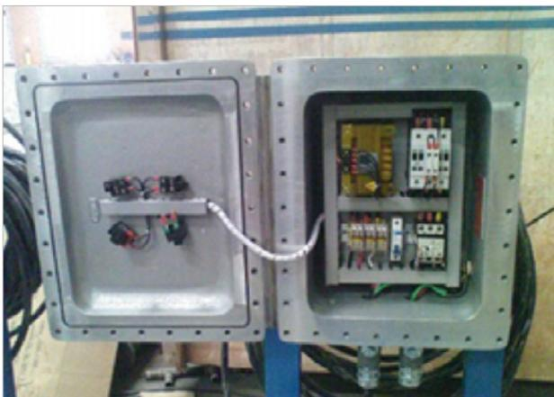
FIGURA 3.12. Eléctrica a prueba de explosión.
