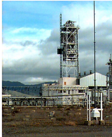
FIGURA 5. Torre central del sistema CRS, en la PSA, Almería, España
