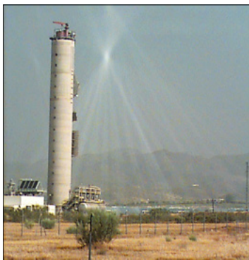
FIGURA 6. Vista frontal de la instalación CESA-I, Plataforma Solar de Almería, España
