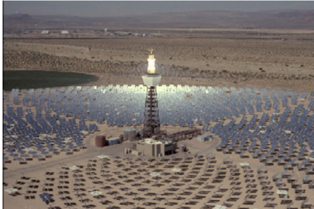
FIGURA 7. Planta Solar Two. Vista aérea de la planta en operación
