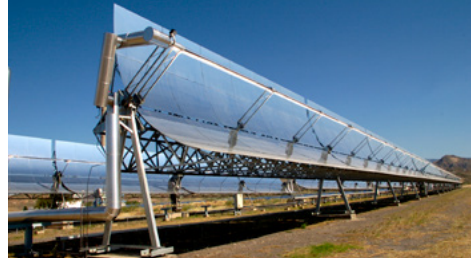
FIGURA 3. Instalación DISS en la Plataforma Solar de Almería, España
