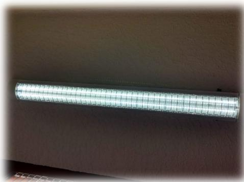
Es una lámpara de estado sólido que está compuesta por varios semiconductores los cuales a cierto nivel de tensión emiten luz. Actualmente las lámparas de led se pueden usar para cualquier aplicación de uso comercial, desde el alumbrado decorativo hasta alumbrado industrial, presentando ciertas ventajas en las que se destaca su considerado ahorro energético.
