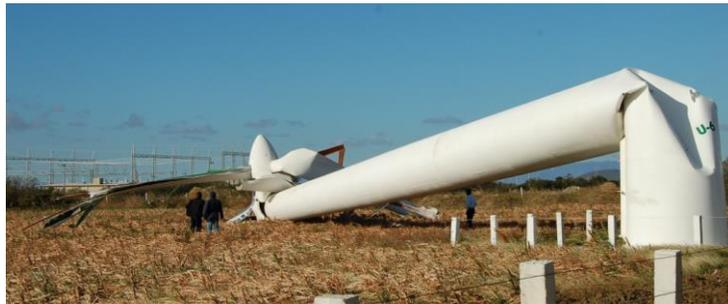
Figura 28. Accidente en aerogenerador en La Venta causado por sobre velocidad
