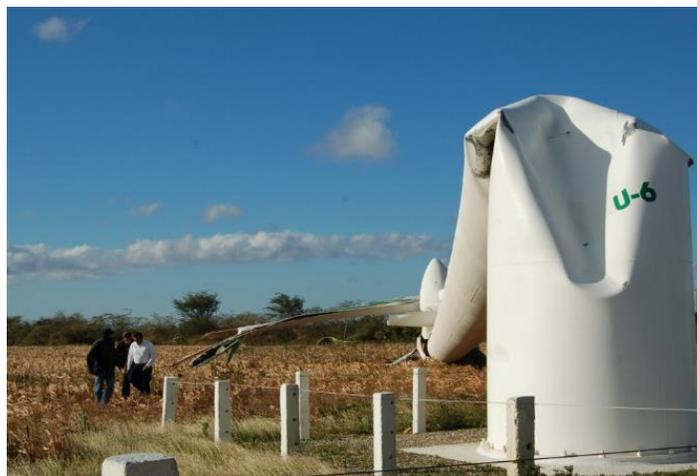
Figura 29. Otra vista del aerogenerador de la marca Vestas derribado por los fuertes vientos en La Venta.
