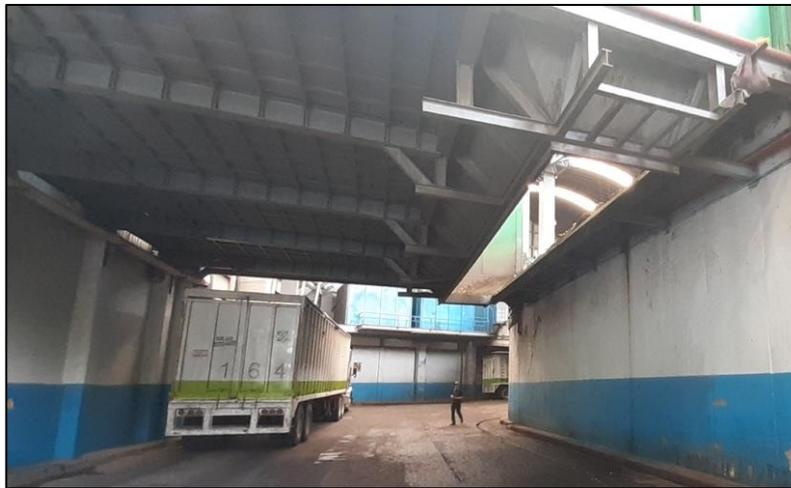
Figura 4.6 Vista inferior de la tolva de residuos orgánicos y un camión de transferencia
