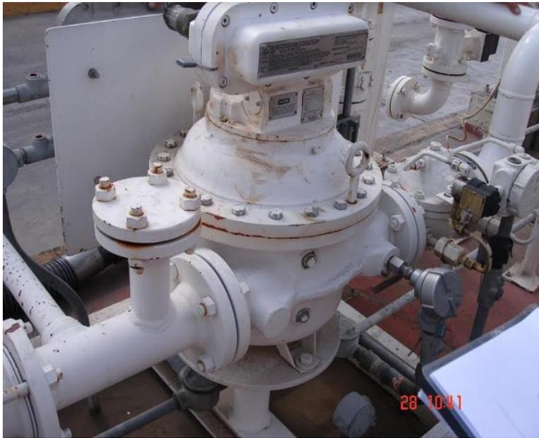
Figura 8. Probador compacto de desplazamiento positivo. Fuente: Tomada en campo de trabajo, 2020.
