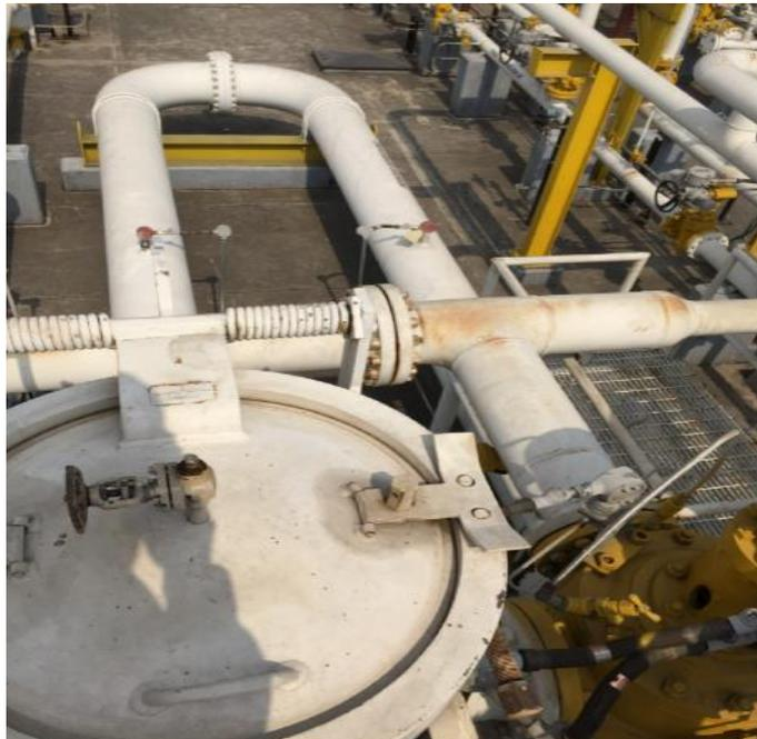
*Figura 5. Probador bidireccional en campo. Fuente: Tomada en campo de trabajo, 2020.*
